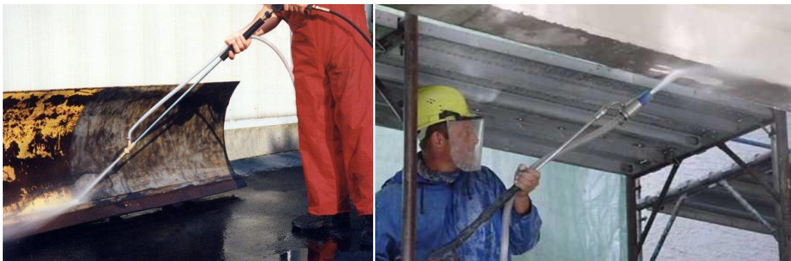
Slika 27. Priprema površine vodenim mlazom [52, 53]
