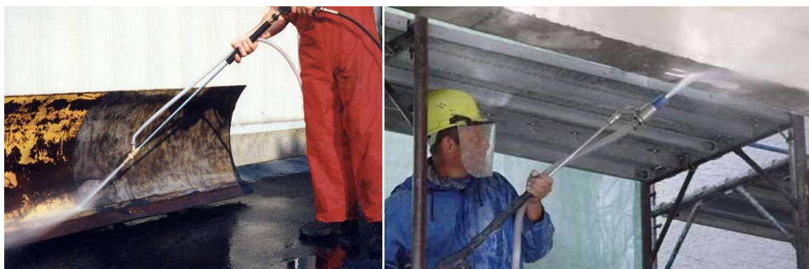
Slika 27. Priprema površine vodenim mlazom [52, 53]
