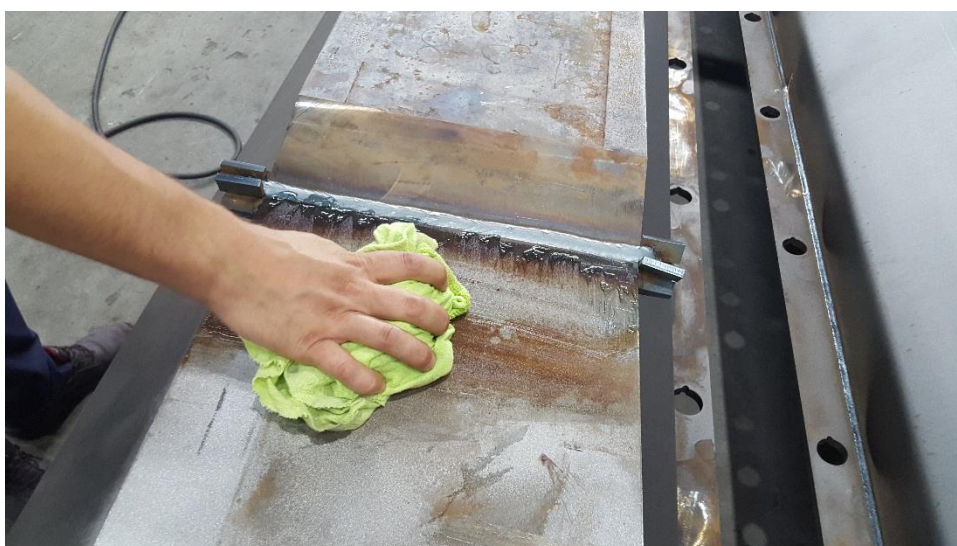
Slika 60: Završno čišćenje površine
