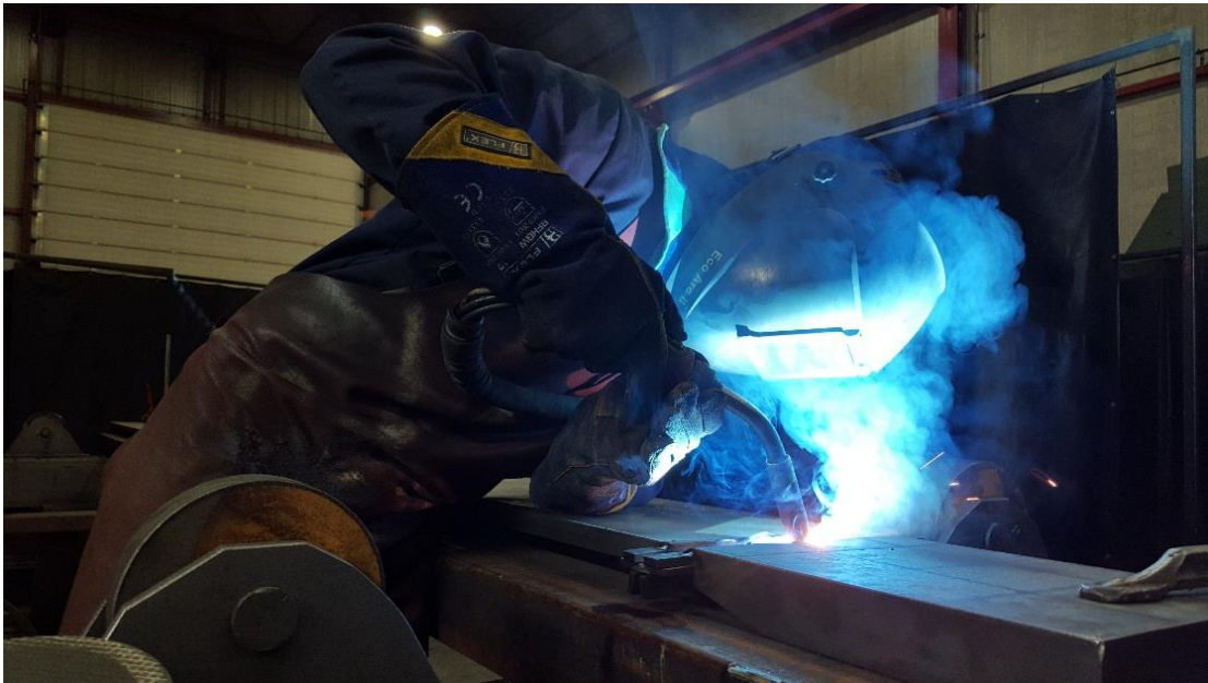
Slika 3: Prikaz zavarivača koji zavaruje MAG postupkom
