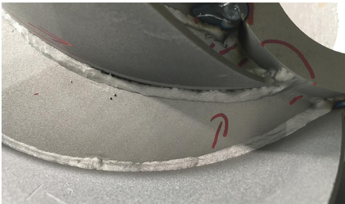
Slika 12: Naljepljivanje utvrđeno vizualnom kontrolom
