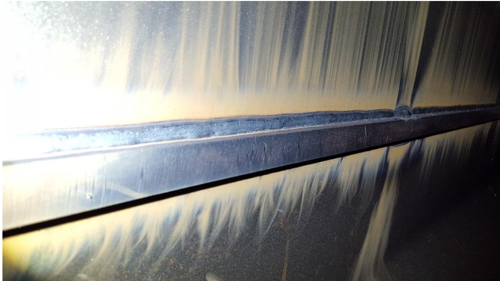
Slika 32: Kontrola provara s unutarnje strane
