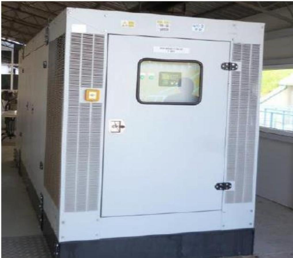
*Slika 2.6. Postojeći diesel agregat 400 kVA za rezervno napajanje vlastite potrošnje elektrane [7]*
