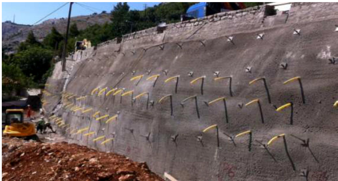
Slika 26. Stabilizacija pokosa sidrima i drenažom
