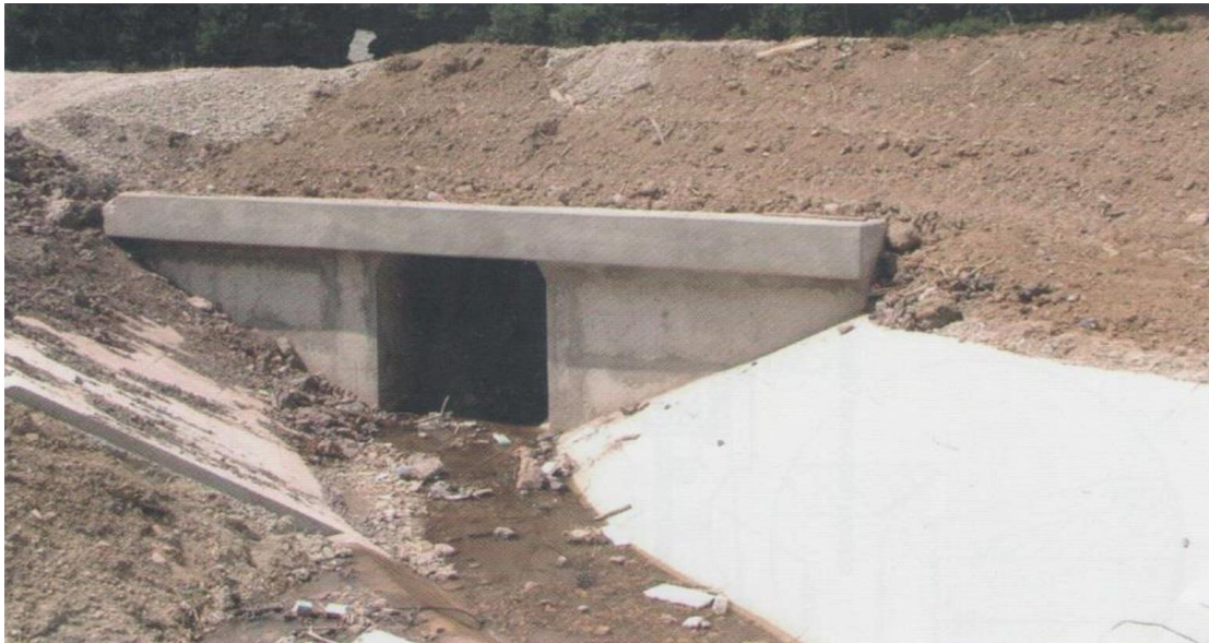
Slika 32. Pločasti betonski propust
