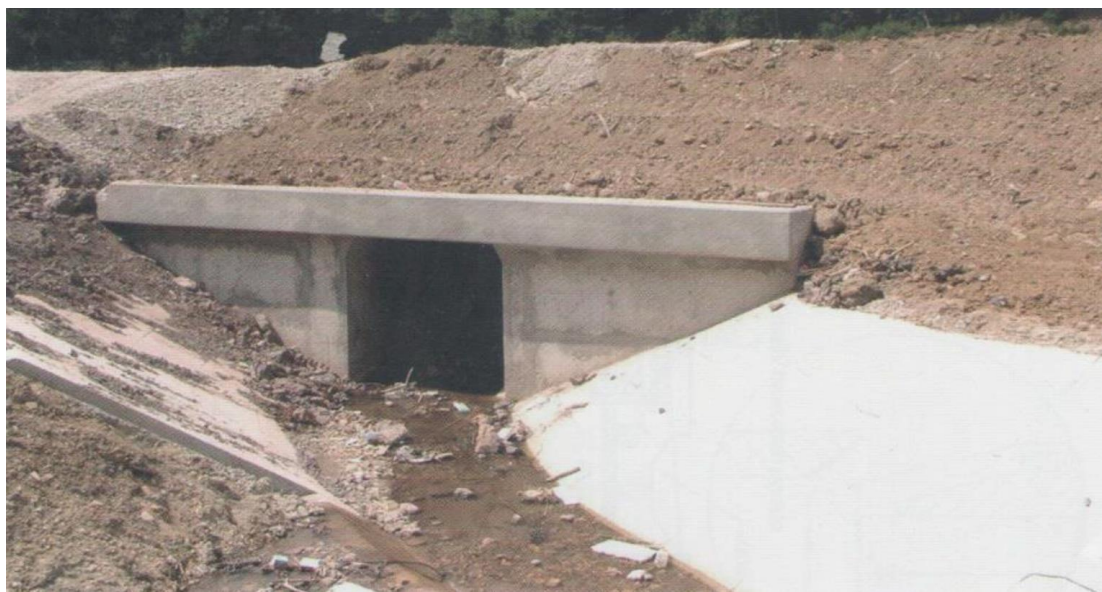
Slika 32. Pločasti betonski propust
