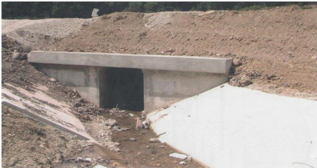
*Slika 32. Pločasti betonski propust*
