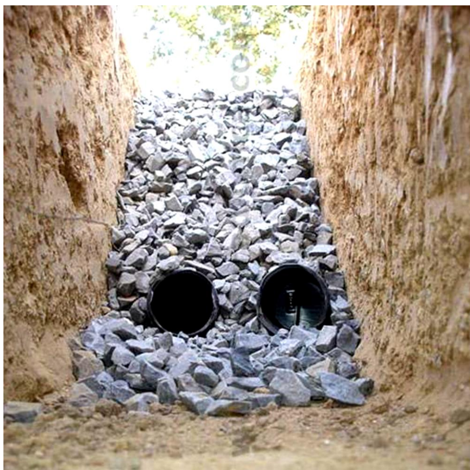
Slika 20. Primjer drenažne cijevi u praksi
