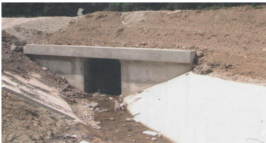
Slika 32. Pločasti betonski propust
