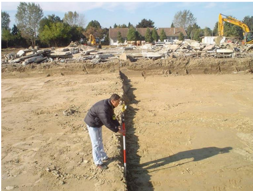
Slika 8 Ocijene i kontrole iskopa
