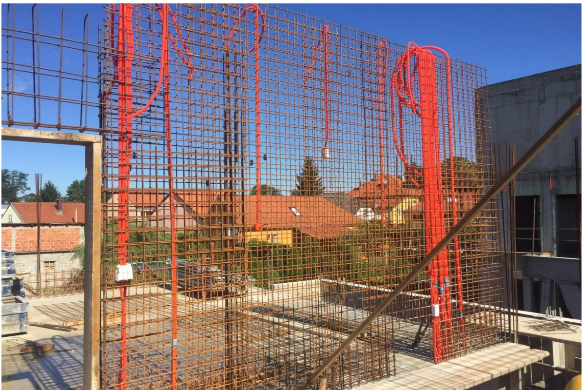
Slika br. 5. Armatura u A.B zidovima, (izvor: vlastiti)
