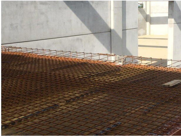
Slika 4. Postava armature
