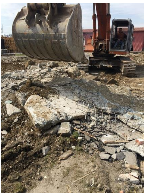
Slika 2. Razbijanje postojećih temelja
