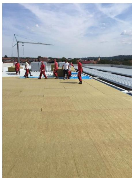
*Slika 13. Termoizolacija neprohodnog krova*
