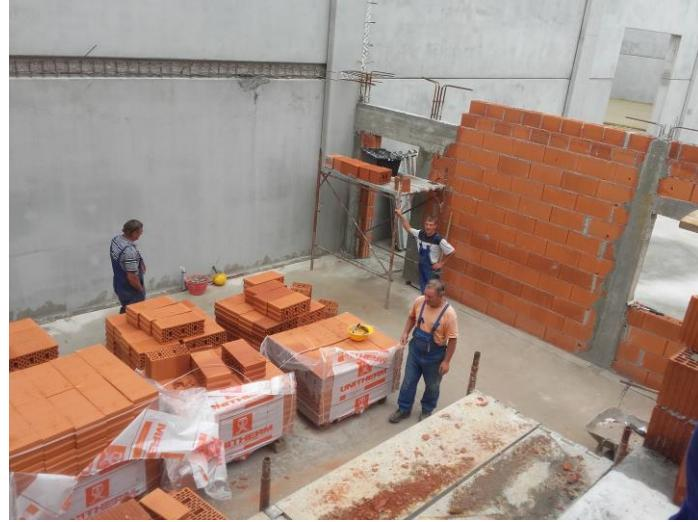
Slika 11. Priprema za zidanje iznad nadvoja
