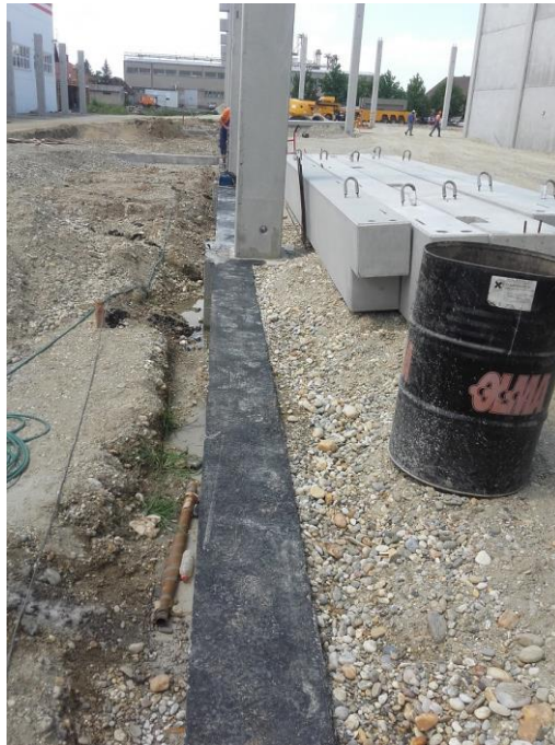
Slika 12. Horizontalna hidroizolacija ispod fasadnih panela
