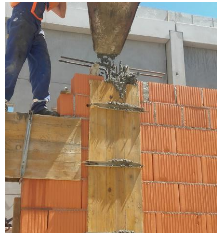
Slika 5. Betoniranje vertikalnih serklaža
