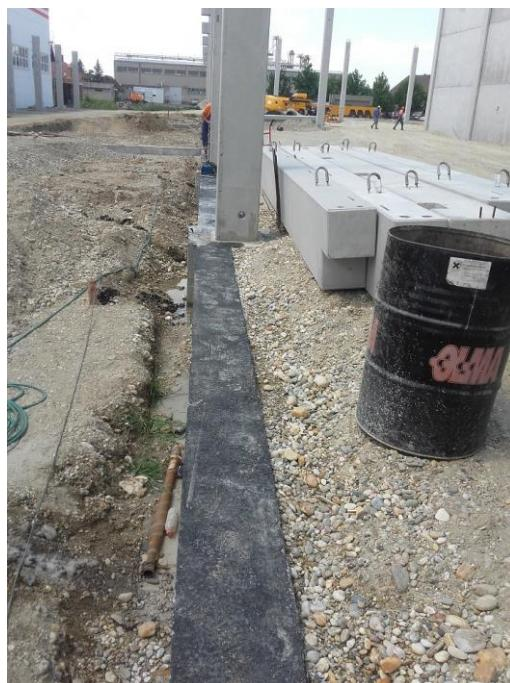
*Slika 12. Horizontalna hidroizolacija ispod fasadnih panela*
