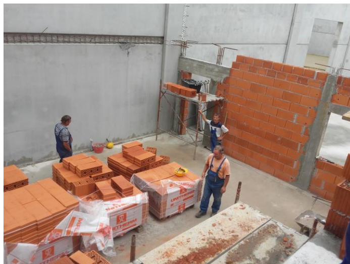
Slika 11. Priprema za zidanje iznad nadvoja
