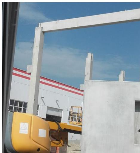
Slika 9. Postavljanje ab montažnih elemenata
