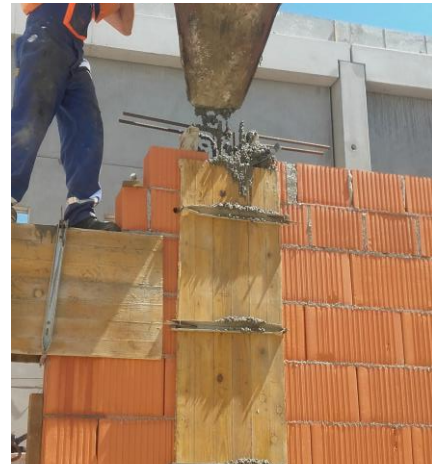
Slika 5. Betoniranje vertikalnih serklaža
