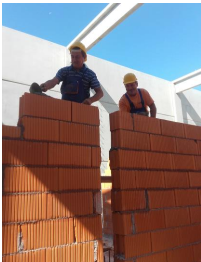
Slika 10. Zidanje nosivih zidova
