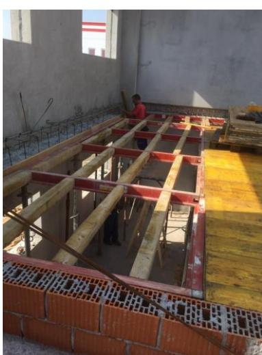
Slika 6. Postavljanje oplate za betoniranje ploče
