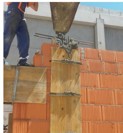
Slika 5. Betoniranje vertikalnih serklaža
