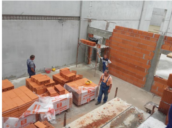
Slika 11. Priprema za zidanje iznad nadvoja
