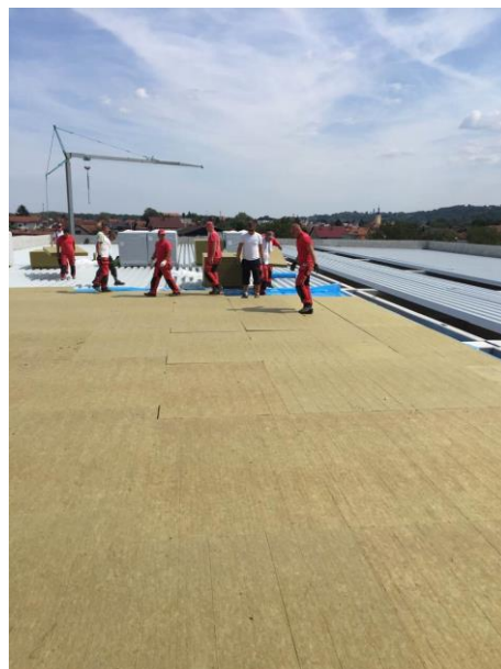
Slika 13. Termoizolacija neprohodnog krova
