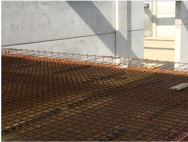
Slika 4. Postava armature
