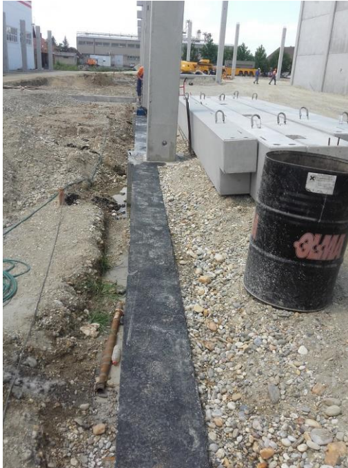
Slika 12. Horizontalna hidroizolacija ispod fasadnih panela
