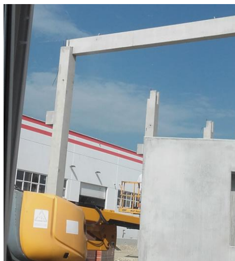
Slika 9. Postavljanje ab montažnih elemenata
