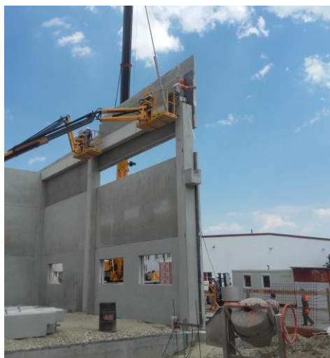
Slika 8. Postavljanje fasadnih panela
