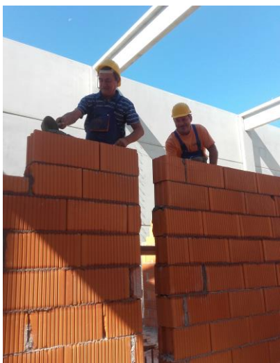
Slika 10. Zidanje nosivih zidova
