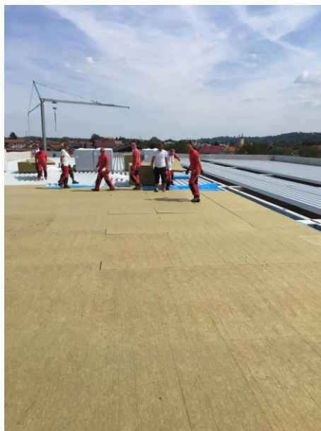
Slika 13. Termoizolacija neprohodnog krova
