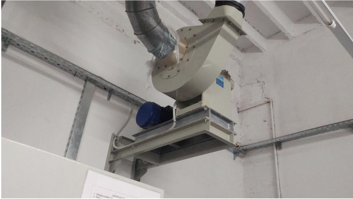
Slika 5.2. Motor ventilatora za cirkulaciju zraka
