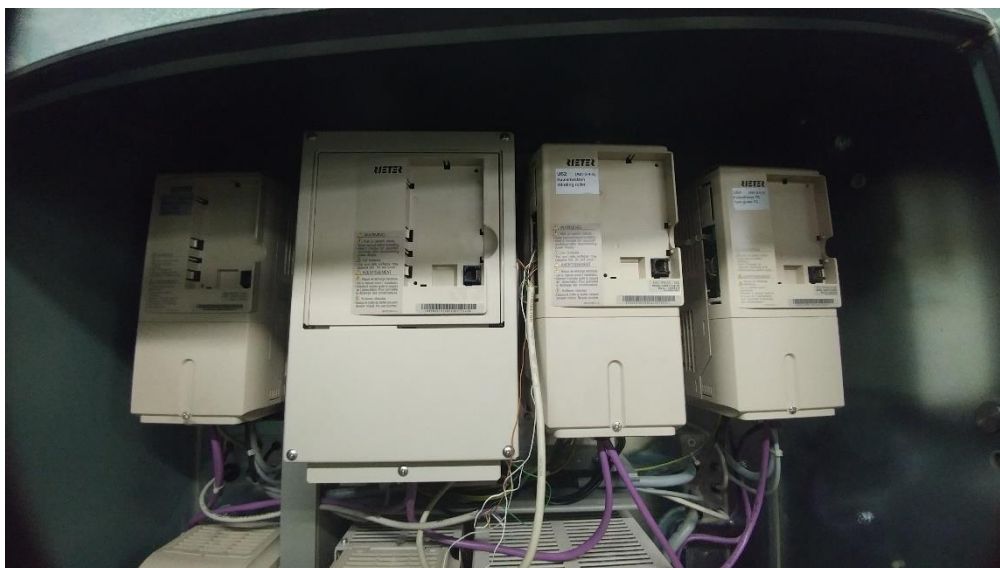
Slika 5.5. Frekvencijski pretvarači OE Rieter
