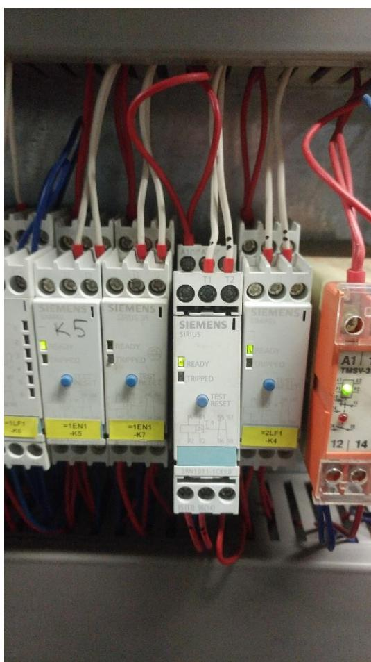
Prateći elektro shemu, povjerava se napon na sklopoljlu u elektro ormaru, i ustanovljeno je da se pokvario relaj termičke zaštite elektromotora prikazan na slici 5.3. Iako je na svojim LED statusnim lampama pokazivao da je sve u redu, aktivirao je kontakte za termičku zaštitu.
