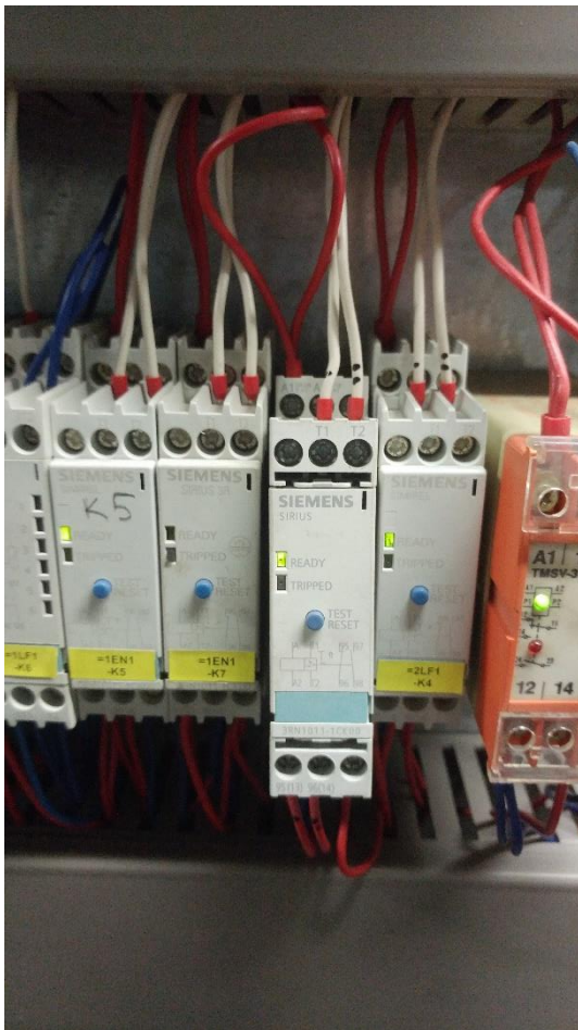
Slika 5.3. Relej termičke zaštite
