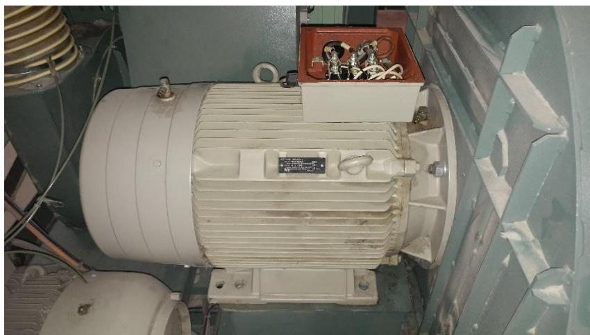
Slika 4.10. Prikaz asinkronog motora od 24,5 kW
