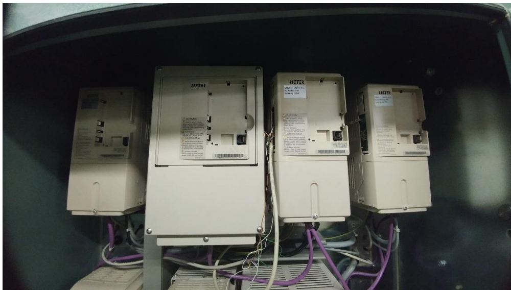
Slika 5.5. Frekvencijski pretvarači OE Rieter
