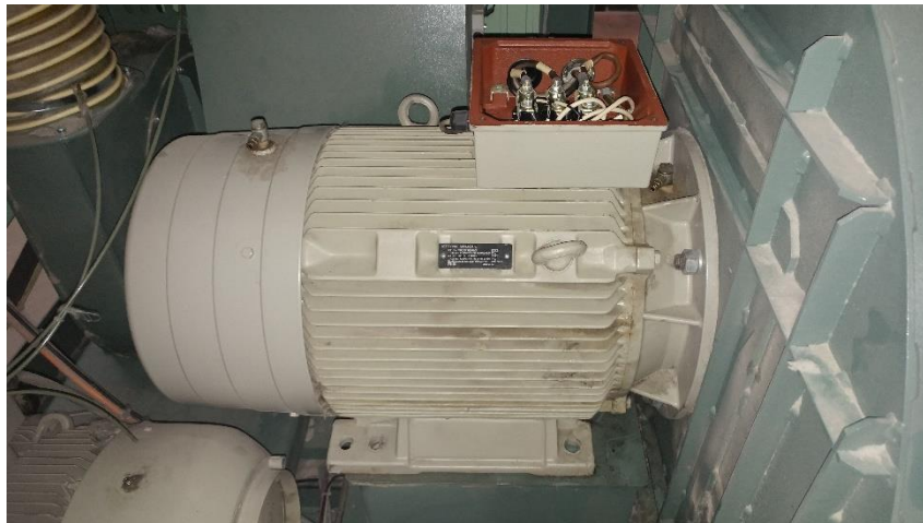
Slika 4.10. Prikaz asinkrona motora od 24,5 kW
