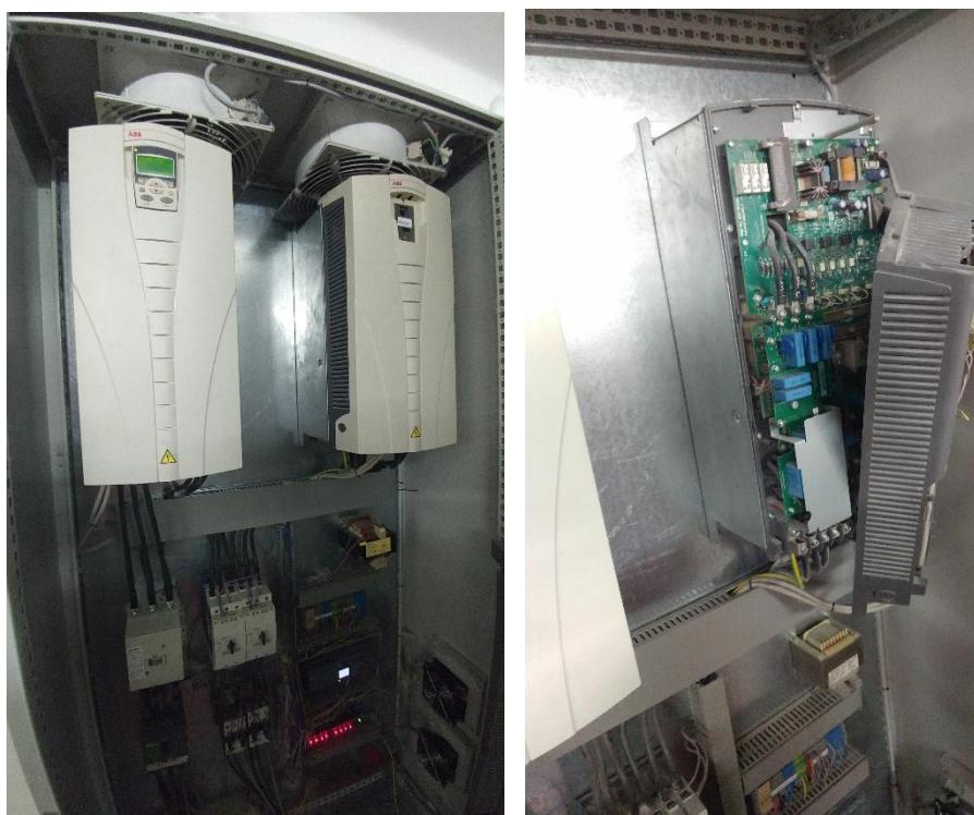
Slika 4.9. Prikaz frekvencijskih pretvarača u elektro ormaru te skidanje poklopca
