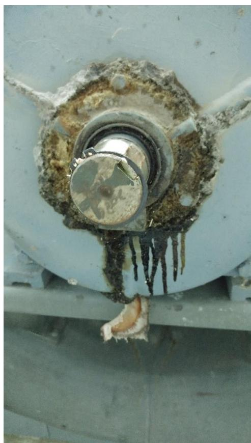
*Slika 4.11. Curenje masti iz 30 kW asinkronog elektromotora zbog povišene temperature*
