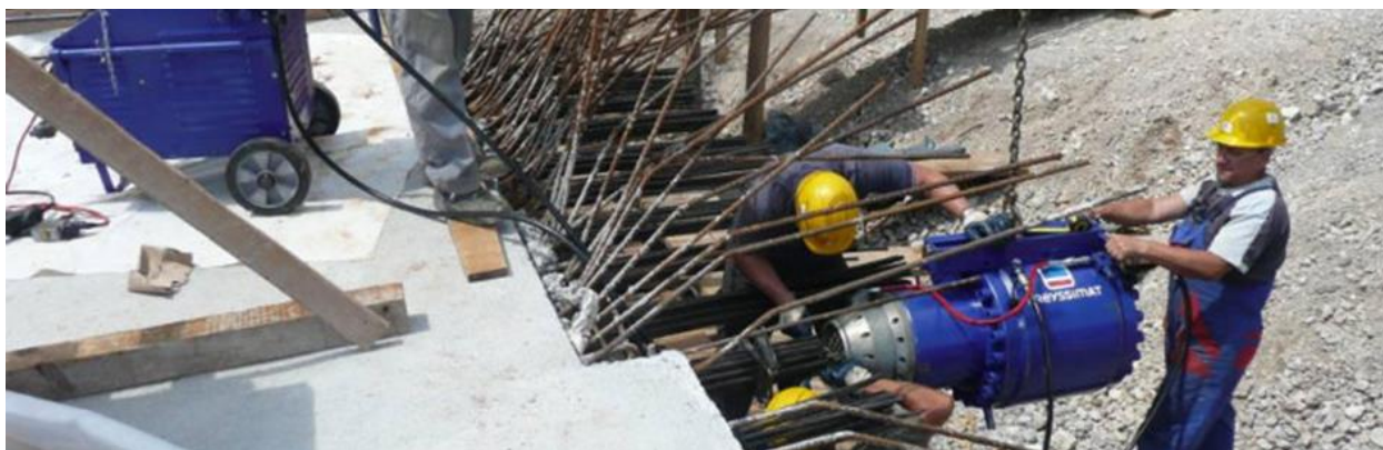
Slika 3.2 Preša za naprezanje kabela
