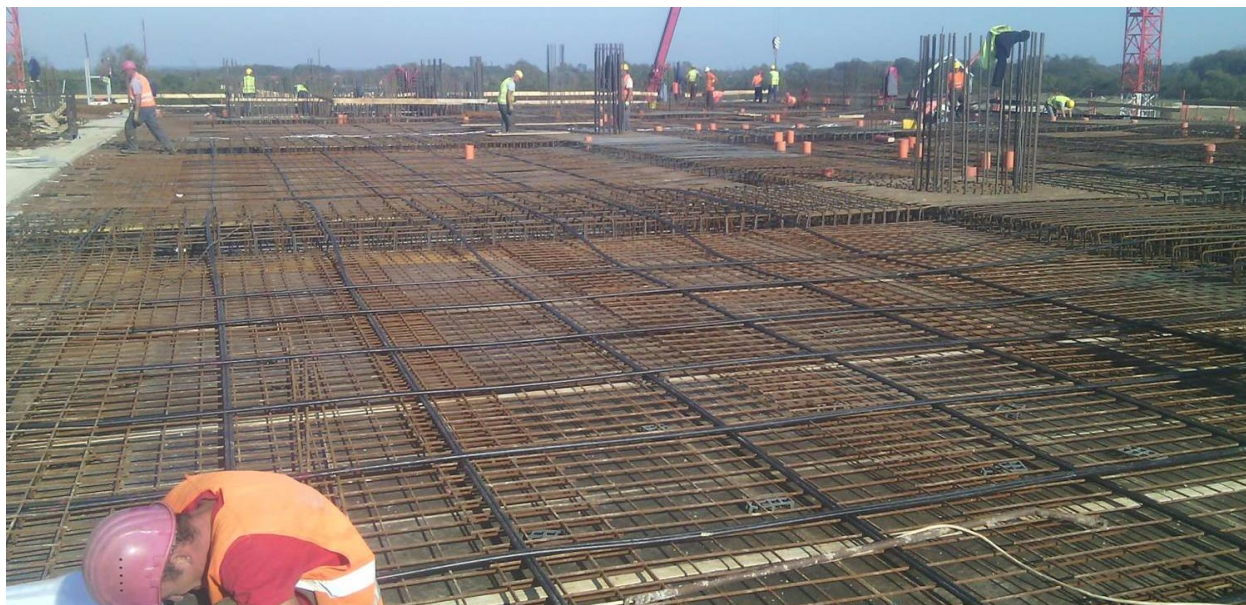
Slika 5.1 Zračna luka u Zagrebu – završne faze polaganja kabela
