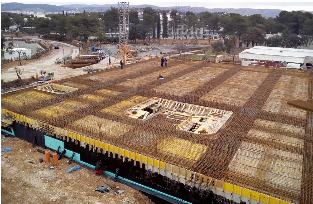
Slika 5.5 Hotelsko naselje Solaris kraj Šibenika – priprema za polaganje kabela
