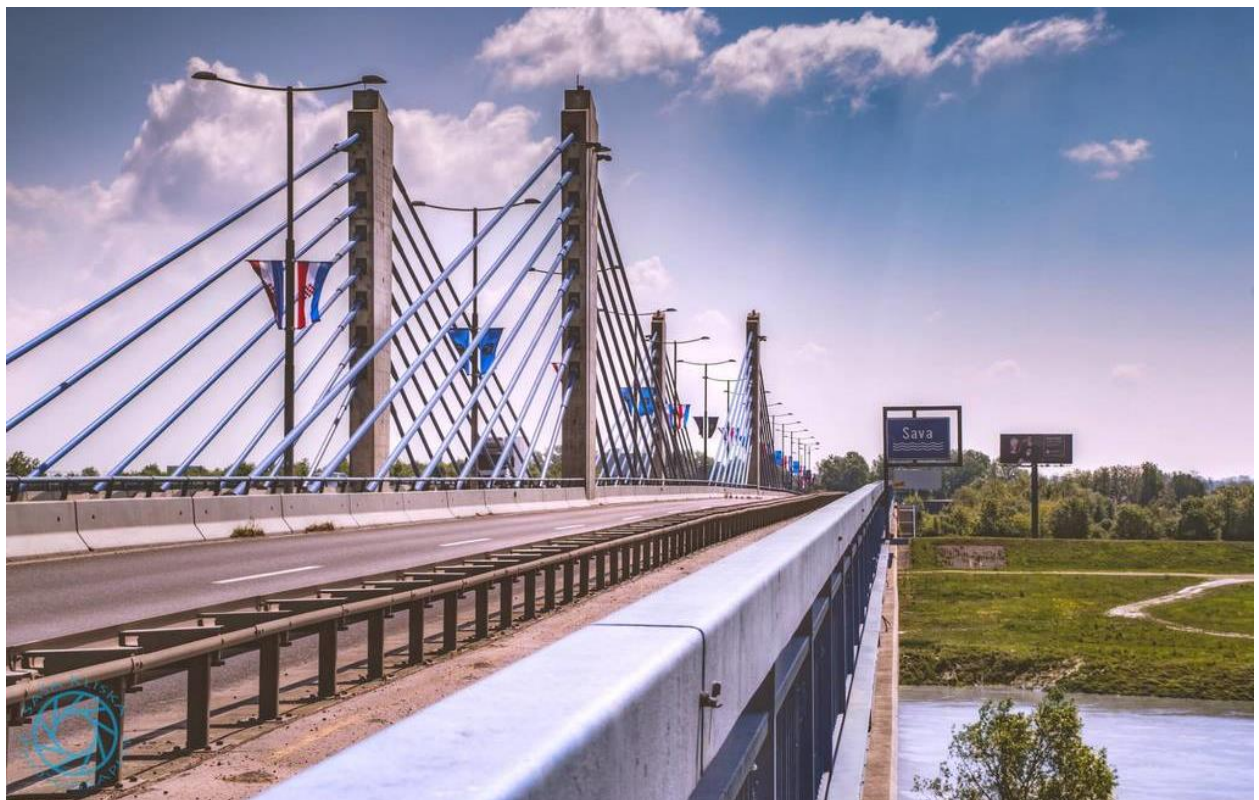
Slika 5.4 Domovinski most na rijeci Savi u Zagrebu – kabeli izvan presjeka
