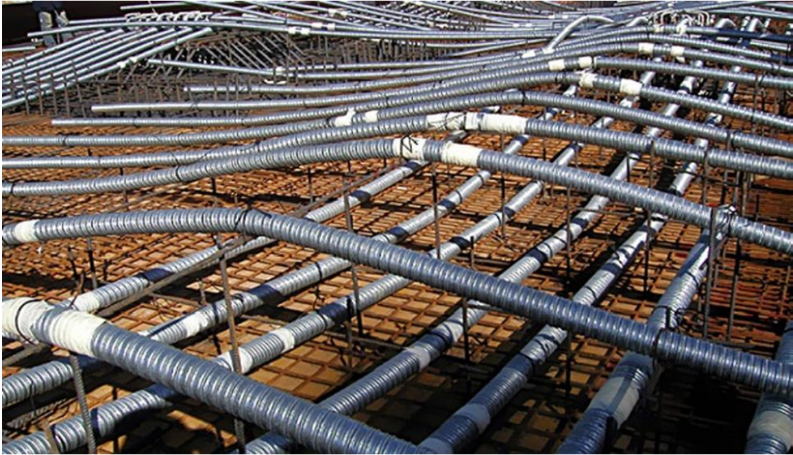
Slika 2.8 Brtvljene i položene zaštitne cijevi
