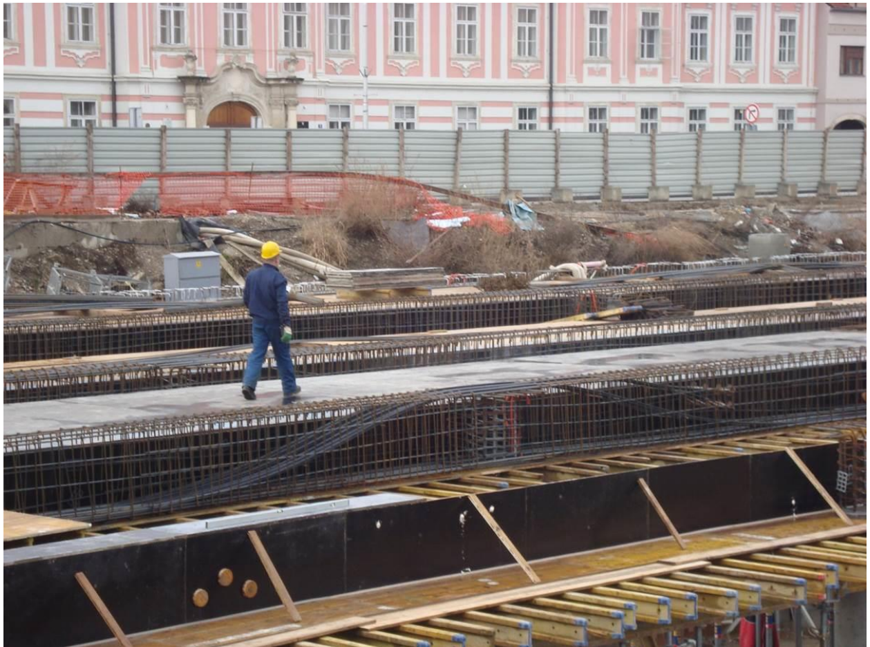
Slika 5.3 Podzemna garaža Kapucinski trg u Varaždinu – položaj kabela u zoni ležaja
