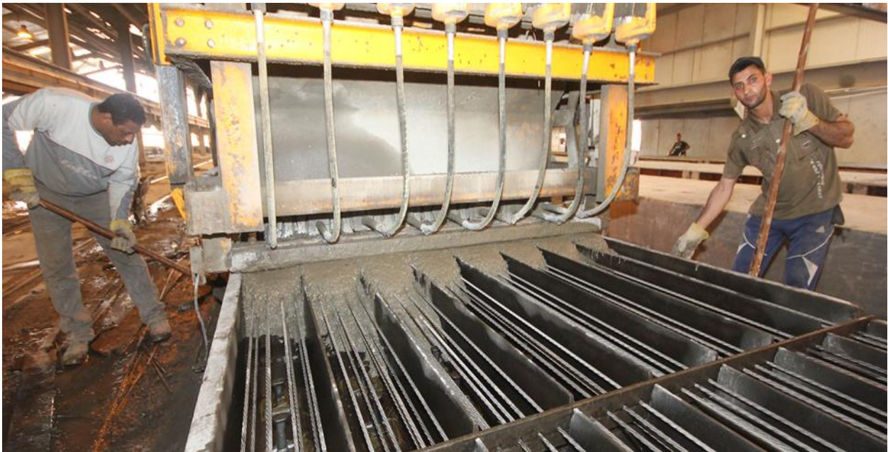
Slika 4.5 Ulijevanje betona u kalupe nakon zatezanja žica
