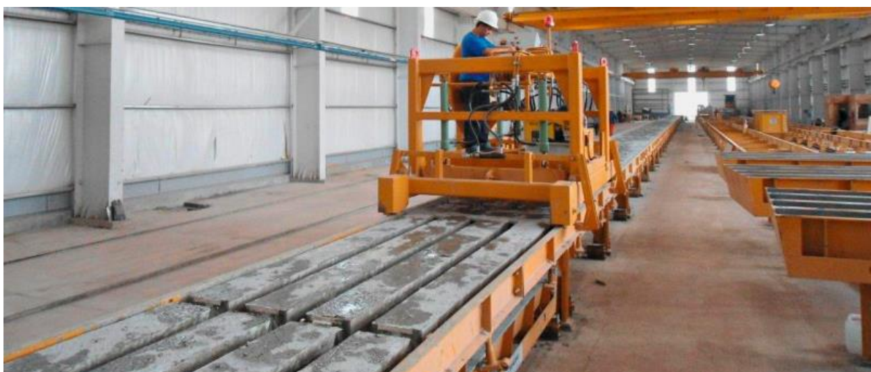
Slika 4.8 Kontrola predgotovljenih betonskih elemenata
