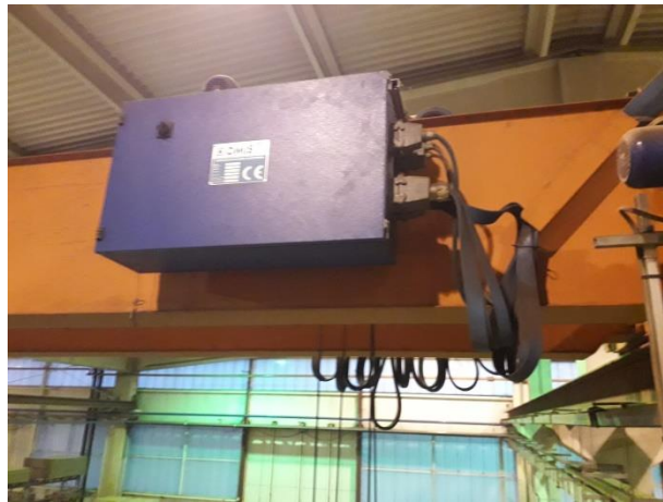
Slika 4.3: Električni ormarić na gredi mosne dizalice [20]
