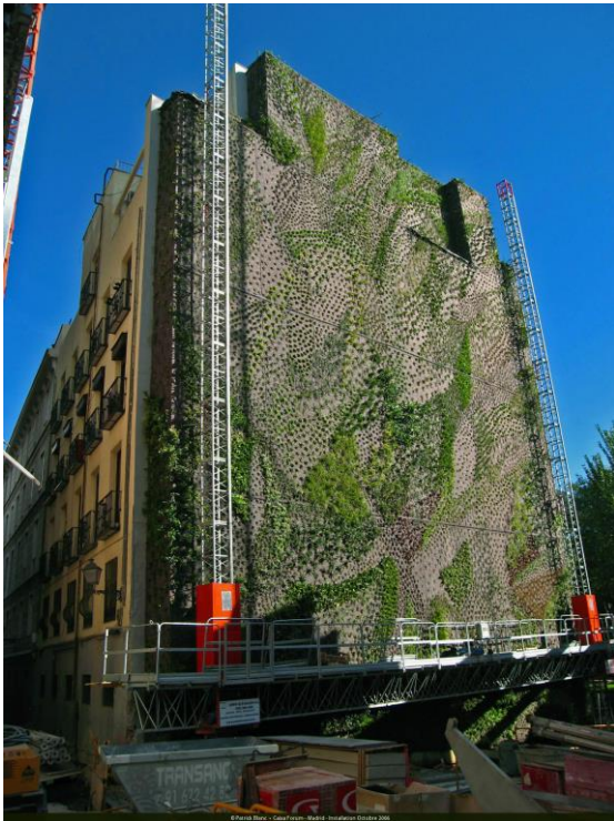
Slika 2.3.2.2.a) Instalacija vertikalnog vrta, listopad 2006.g.
