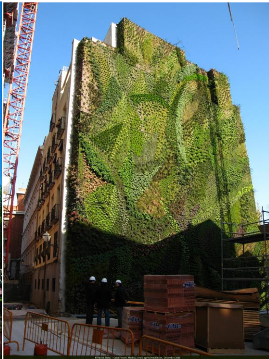
Slika 2.3.2.2.b) Dva mjeseca nakon instalacije, prosinac 2006.g.
