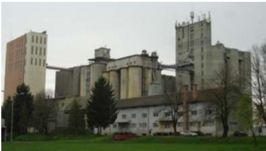
Slika 9: Silos u "Đuro Salaj"
