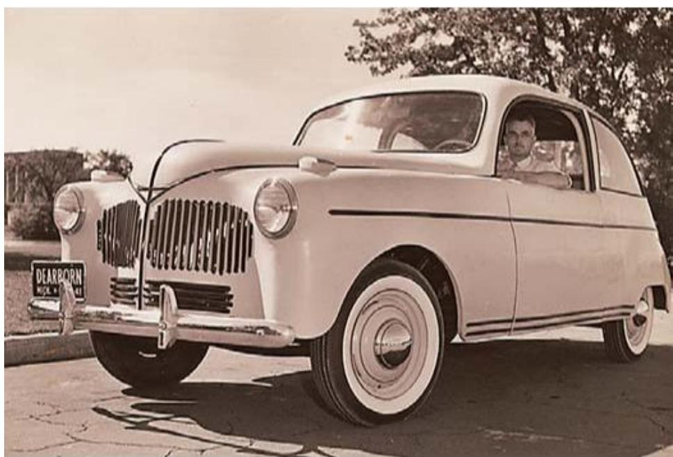
Slika 1. Fordov automobil od duromernog kompozita s konopljom [3]
