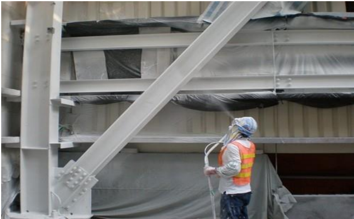
Slika 5.4. Prskanje metalne konstrukcije temeljnom bojom
