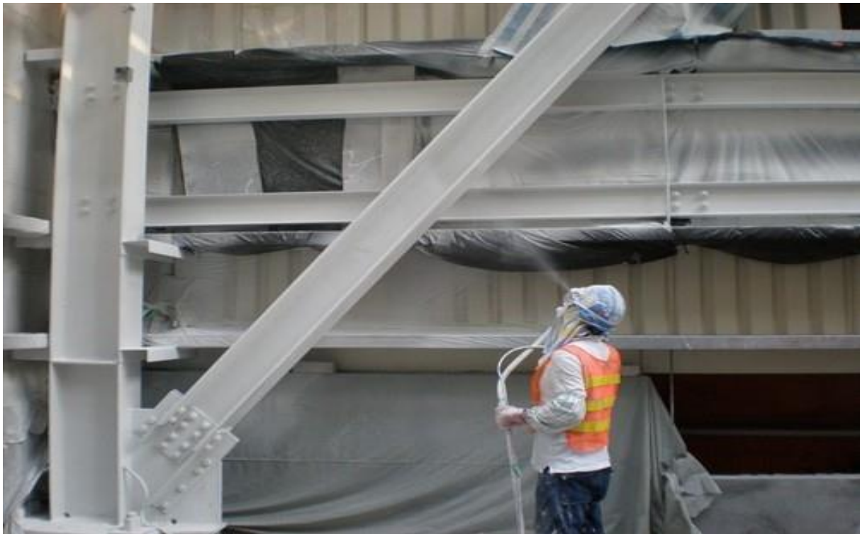
Slika 5.4. Prskanje metalne konstrukcije temeljnom bojom
