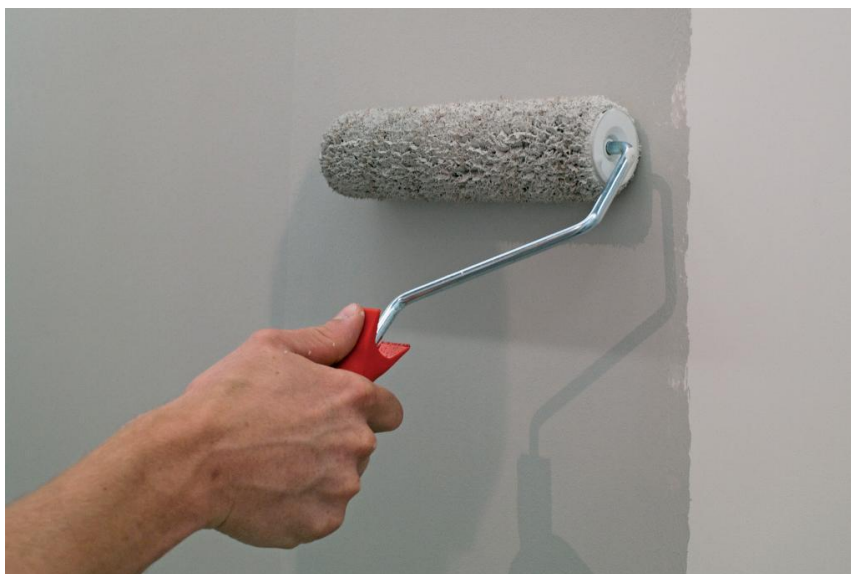
Slika 5.8. Nanošenje boje valjkom
