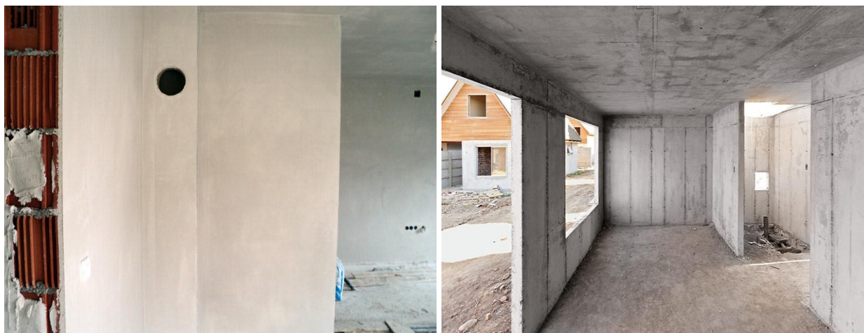
Slika 5.6. Ožbukana i betonska mineralna podloga
