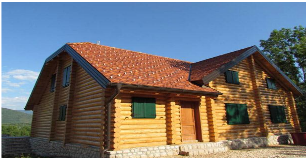
Slika 5.2. Drvena kuća premazana lazurnom bojom
