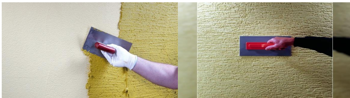
Slika 5.10. Nanošenje i obrada završno dekorativne žbuke
