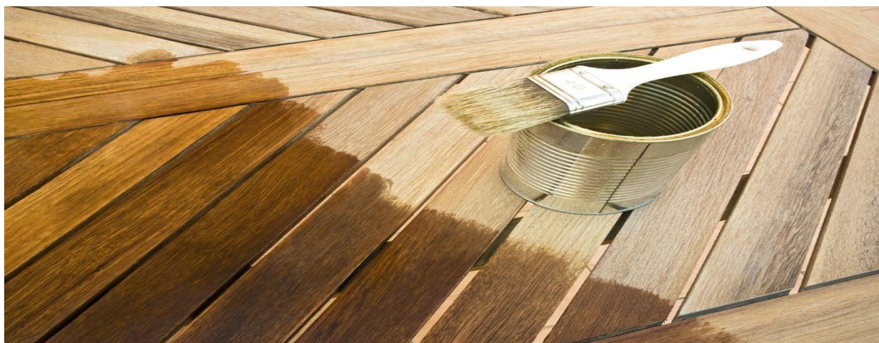
Slika 5.1. Premazivanje lazurnom bojom
