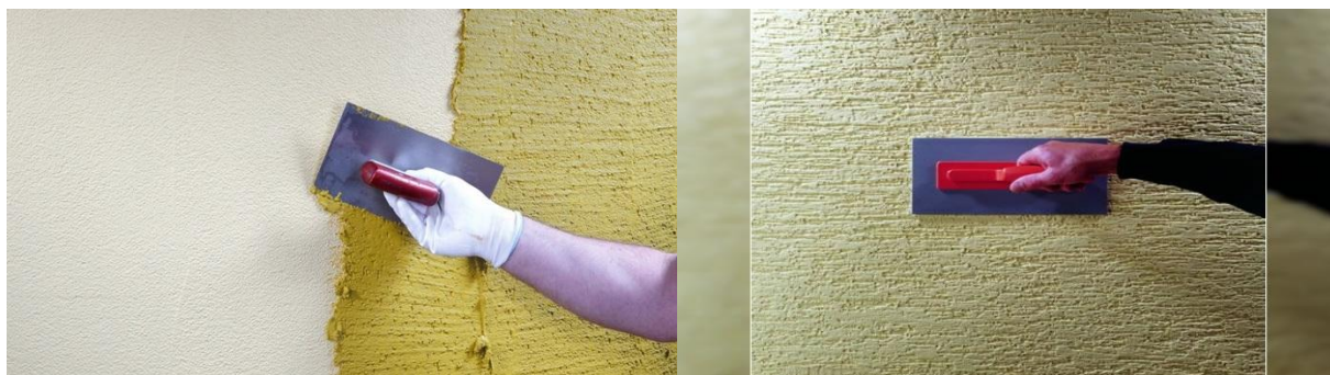
Slika 5.10. Nanošenje i obrada završno dekorativne žbuke
