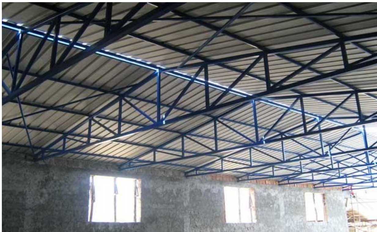
Slika 5.5. Metalna konstrukcija obojana pokrivnom lak bojom
