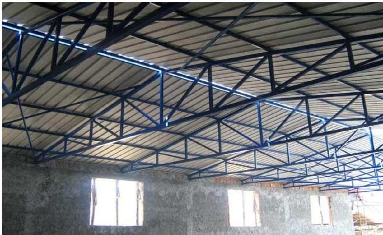
Slika 5.5. Metalna konstrukcija obojana pokrivnom lak bojom
