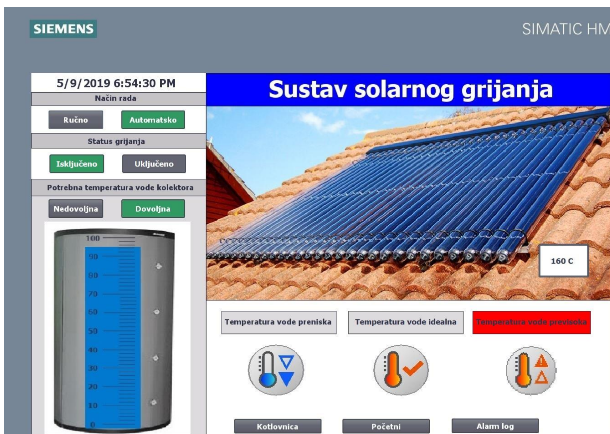
Slika 5.10 Isključivanje sustava radi prevelike temperature
