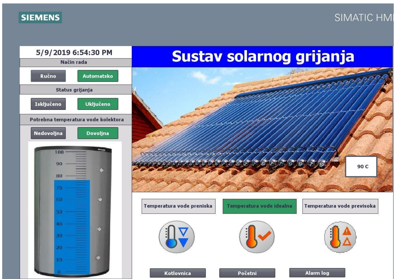
Slika 5.9 Sustav solarnog grijanja
