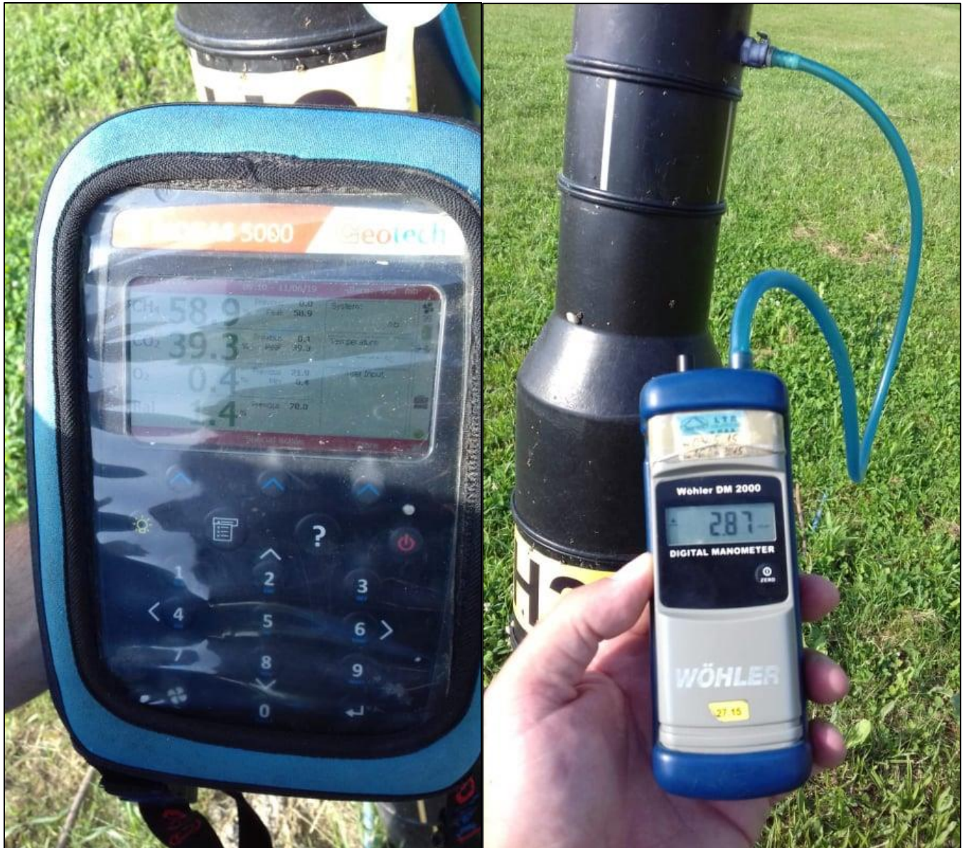
Slika 6.2. i 6.3. Mjerenje plina na sondama uređajima, postotak prisutnosti plina (CH 4 , lijevo), pritisak tlaka (desno)
