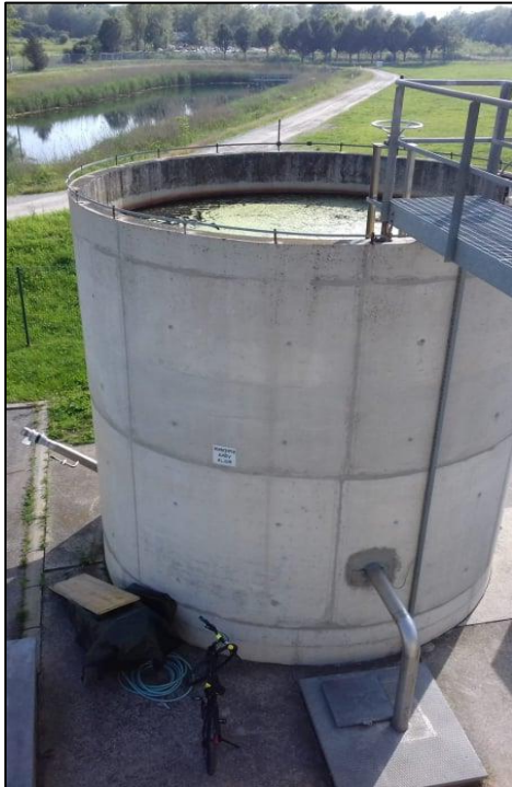
Slika 9.4. Spremnik viška mulja
