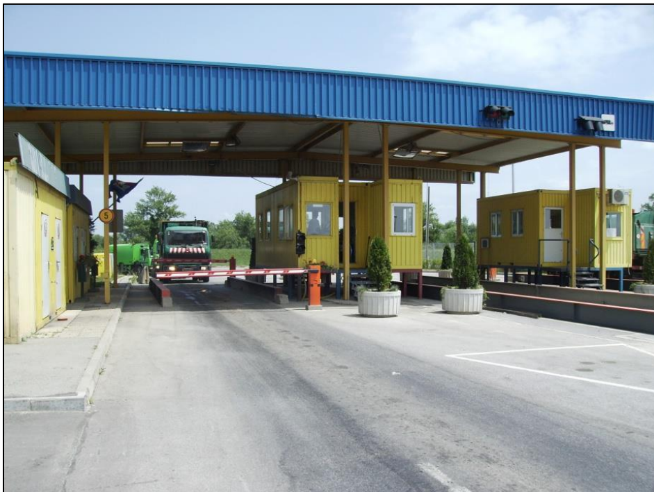
Slika 3.2. Ulaz kamiona na odlagalište otpada
