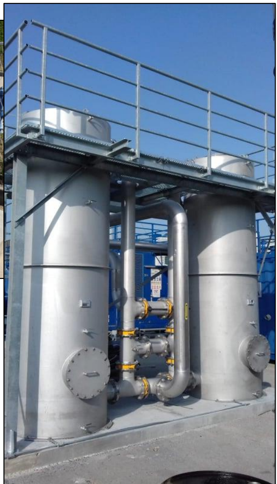
Slika 7.4. Jedinica s aktivnim ugljenom
