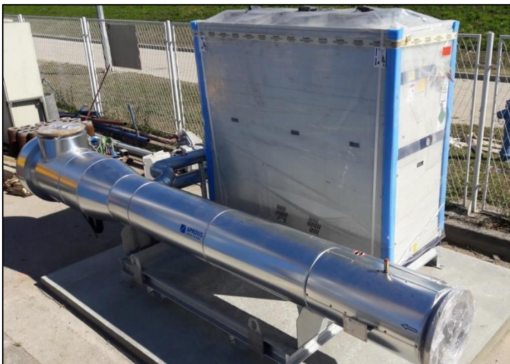
Slika 7.3. Odvlaživač plina
