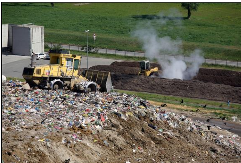
Slika 5.1. Kompaktor koji provodi zbijanje otpada po propisima
