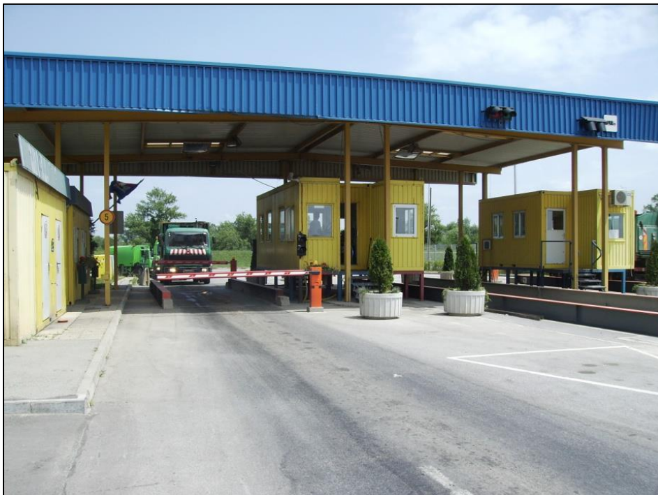
Slika 3.2. Ulaz kamiona na odlagalište otpada
