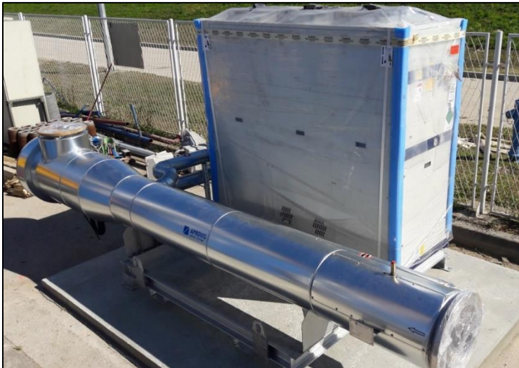
Slika 7.3. Odvlaživač plina
