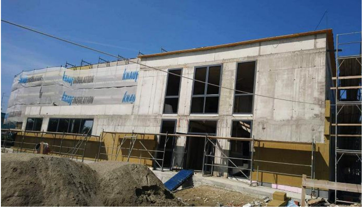
Slika 3.9 Termoizolaterski radovi ( Izvor: autor )
