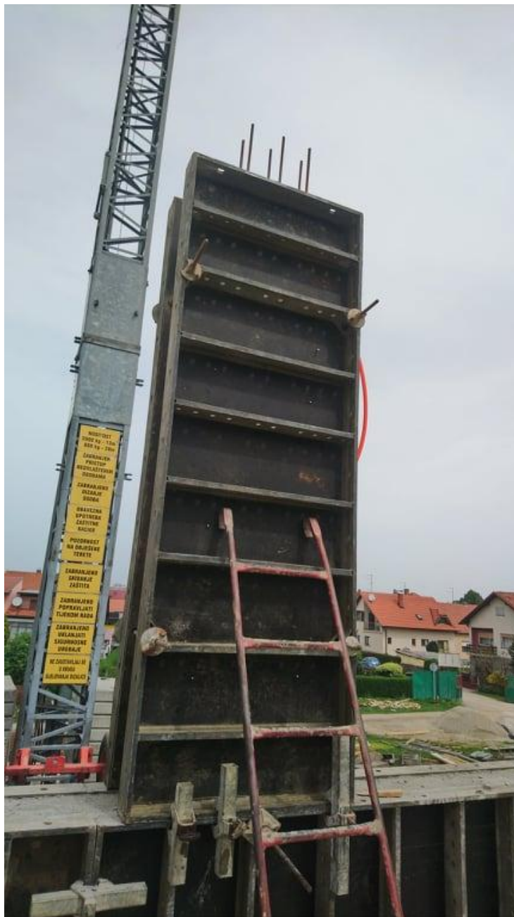
Slika 3.6 Zidna (kranjska) oplata ( Izvor: autor )
