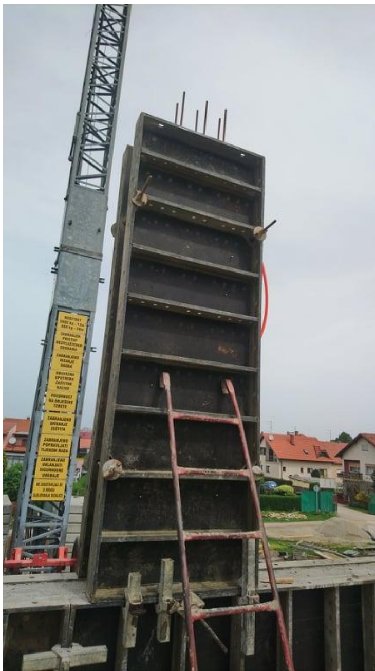
Slika 3.6 Zidna (kranjska) oplata ( Izvor: autor )
