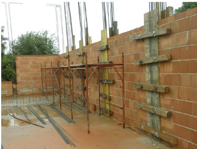
Slika 3.7 Zidarski radovi ( Izvor: autor )
