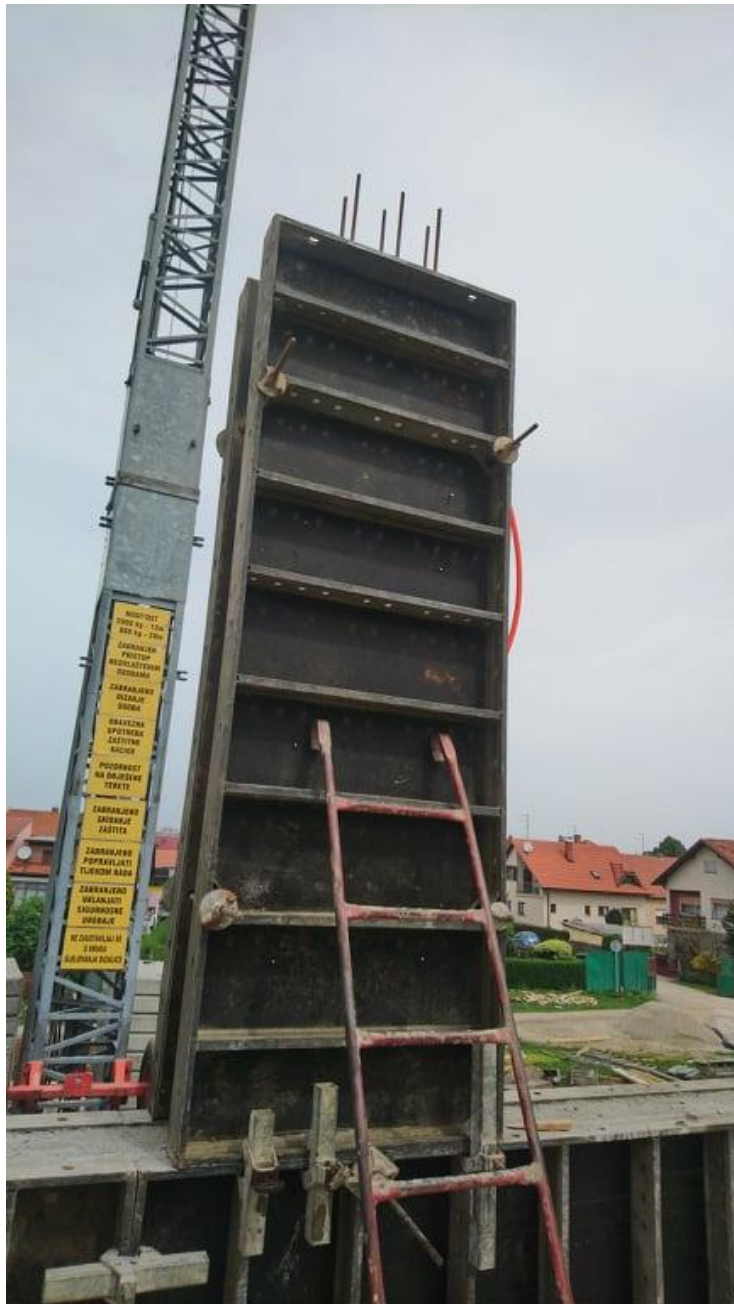
Slika 3.6 Zidna (kranjska) oplata ( Izvor: autor )
