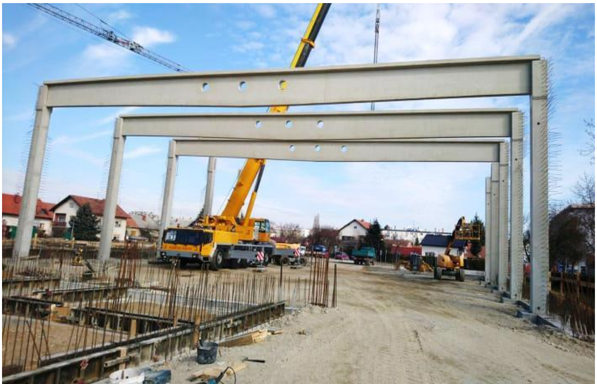
Slika 3.4 Prikaz montažnih betonskih greda ( Izvor: autor )
