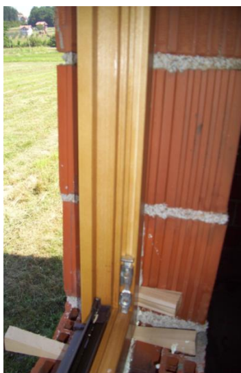
Slika 2.1. Ugradnja prozora prije žbukanja
