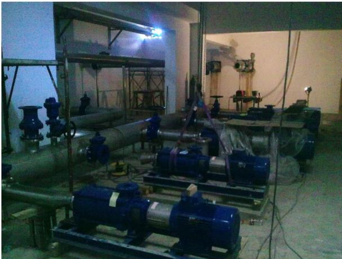
Slika 3.13 Prikaz montiranja i rasporeda pumpi
