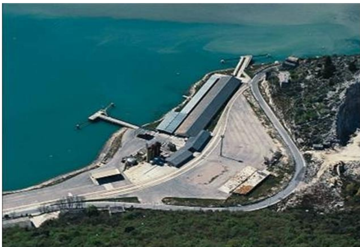
Slika 5.17. Terminal Bršica iz zraka (Izvor: https://lukarijeka.hr/ )
