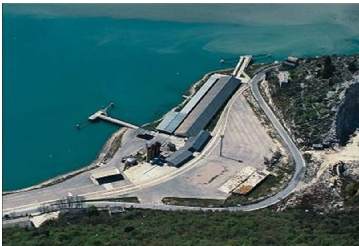
Slika 5.17. Terminal Bršica iz zraka (Izvor: https://lukarijeka.hr/ )
