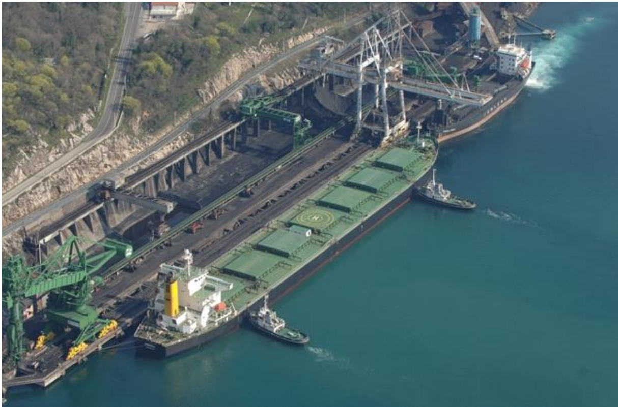
Slika 5.5. Terminal za rasute terete (Bakar) (Izvor: https://lukarijeka.hr/ )
