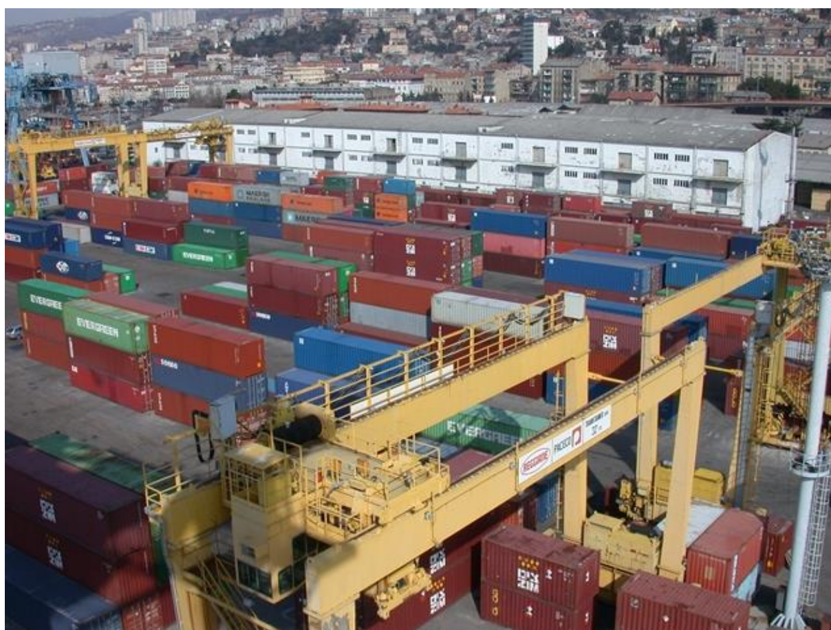
Slika 5.11. Kontejnerski terminal (Izvor: https://lukarijeka.hr/ )
