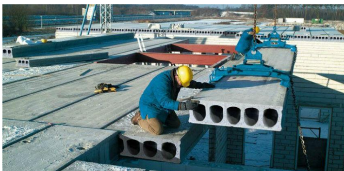
Slika 2.15 Prikaz montaže šupljih ploča
