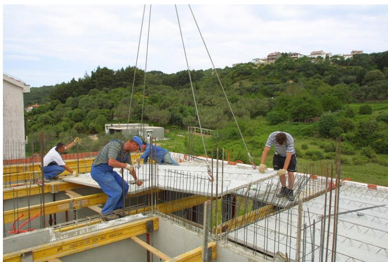
Slika 2.16 Prikaz montaže omnie ploče
