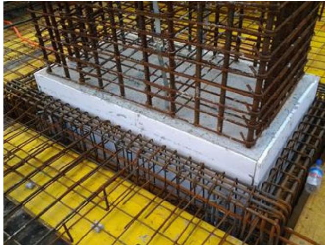
Slika 3.5 Prikaz dilatiranja stupa
