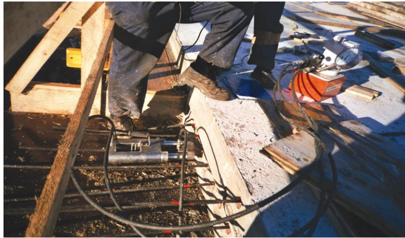
Slika 2.19 Postupak prednaprezanja pomoću hidraulične preše za „unbonded“ kabele
