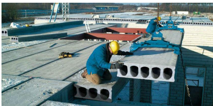
Slika 2.15 Prikaz montaže šupljih ploča
