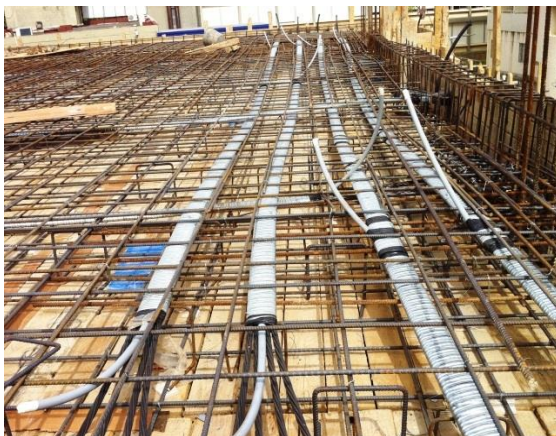
Slika 2.20 „Bonded“ i „unbonded“ kabele za prednaprezanje
