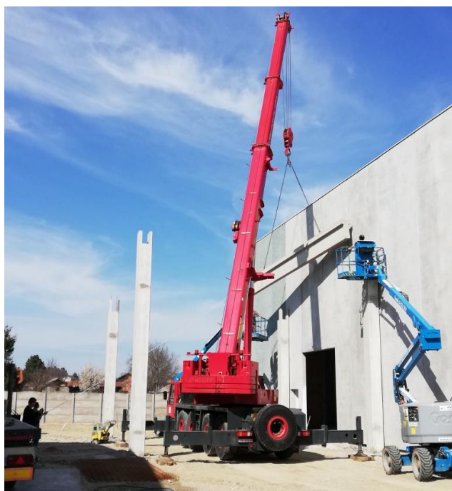
Slika 4.12. Montaža nosača nadstrešnice autodizalicom
