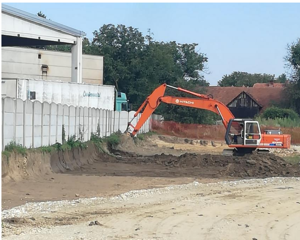
Slika 4.1. Strojni iskop materijala III. kategorije
