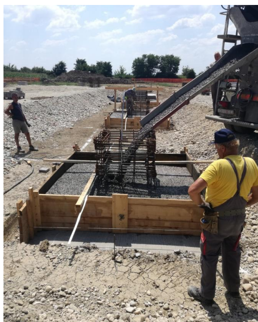
Slika 4.8. Betoniranje temeljne stope
