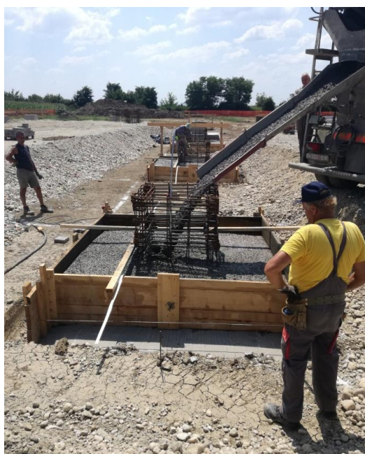
Slika 4.8. Betoniranje temeljne stope
