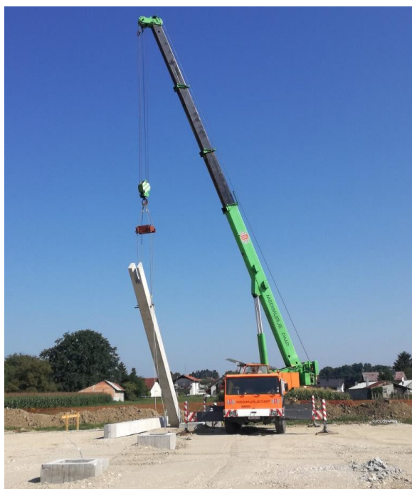
Slika 4.11. Montaža AB stupa autodizalicom
