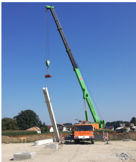
Slika 4.11. Montaža AB stupa autodizalicom
