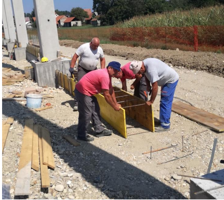
Slika 4.4. Postava oplata temeljnih traka
