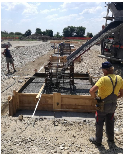
Slika 4.8. Betoniranje temeljne stope
