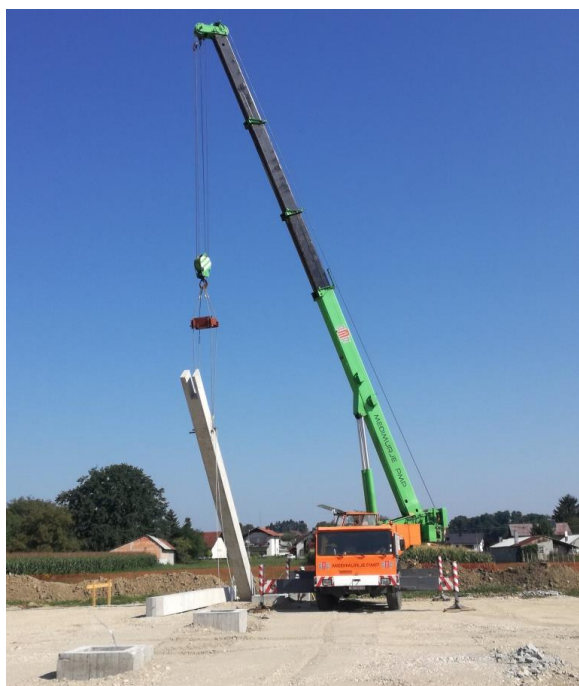
Slika 4.11. Montaža AB stupa autodizalicom
