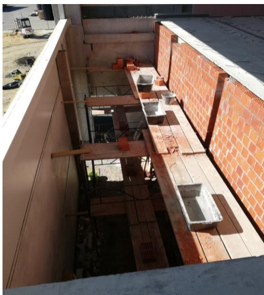
Slika 4.13. Unutarnji pregradni zidovi izvedeni šupljom opekom
