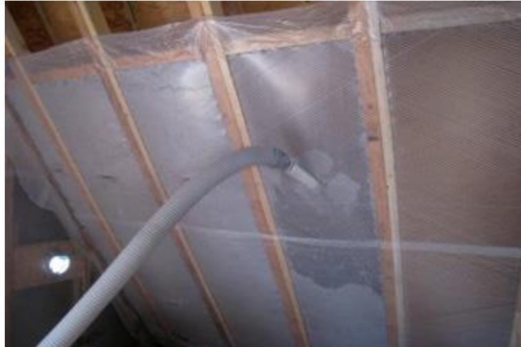
Slika 4.12 Ugradnje celuloze metodom upuhivanja
