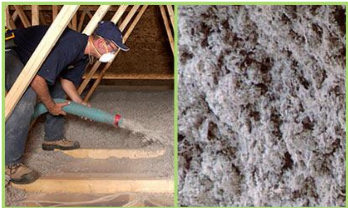
Slika 4.13 Ugradnja celuloze metodom špricanja
