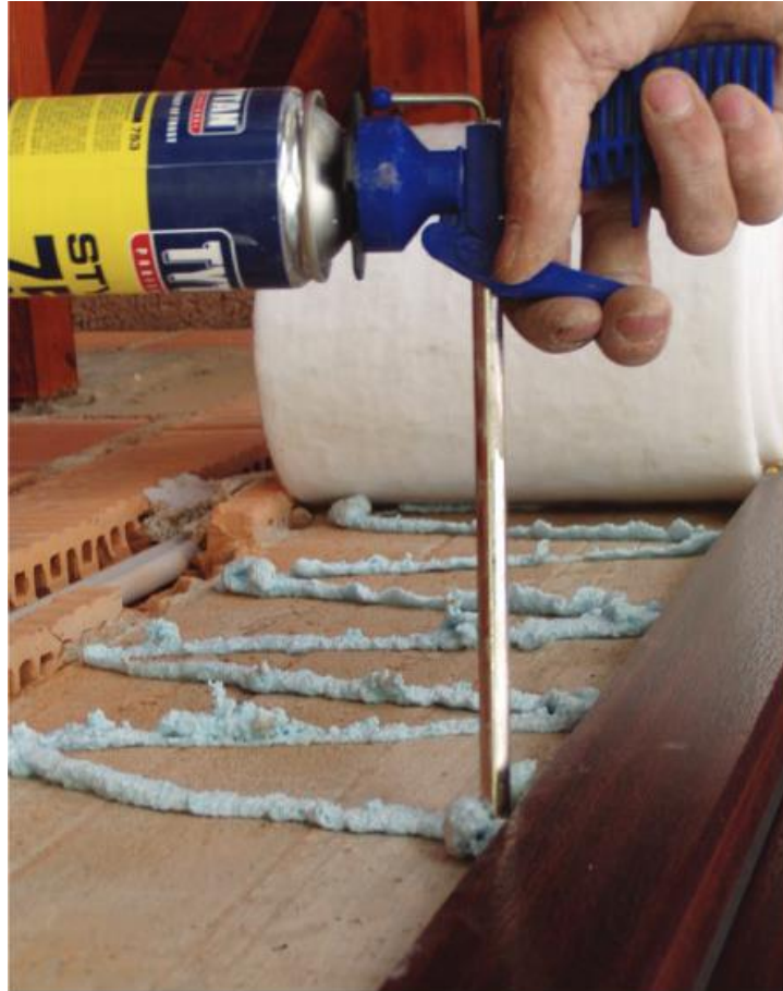
Slika 4.28 Primjena aerogela
