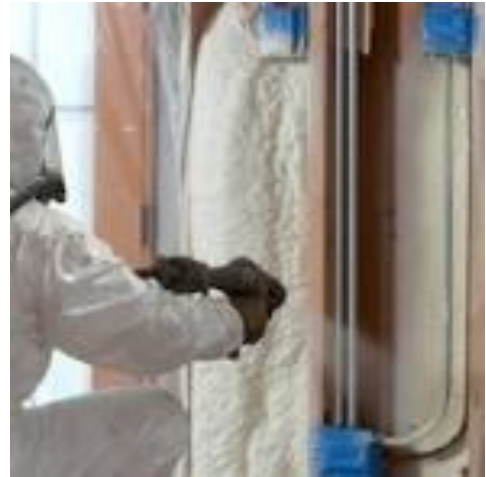
Slika 4.9 Metoda prskanja poliuretanske pjene pištoljem
