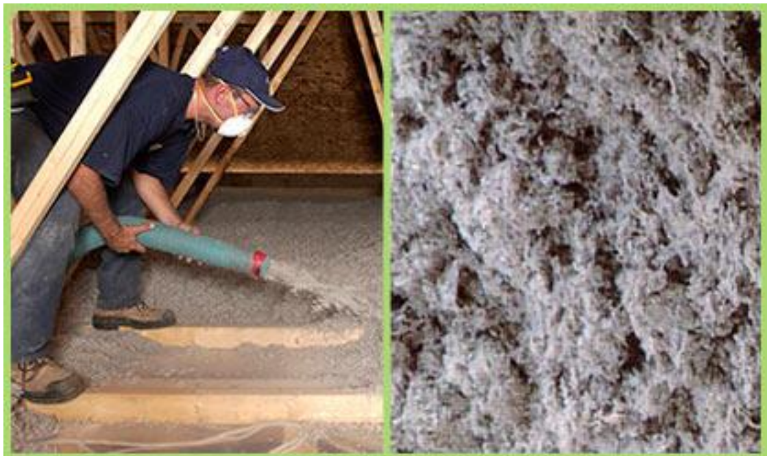
Slika 4.13 Ugradnja celuloze metodom špricanja
