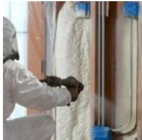
Slika 4.9 Metoda prskanja poliuretanske pjene pištoljem
