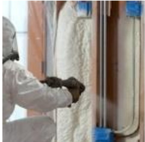
Slika 4.9 Metoda prskanja poliuretanske pjene pištoljem
