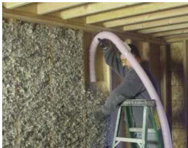
Slika 4.21 Ugradnja ovčje vune
