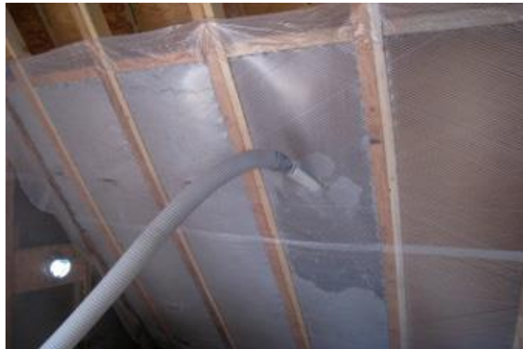
Slika 4.12 Ugradnje celuloze metodom upuhivanja
