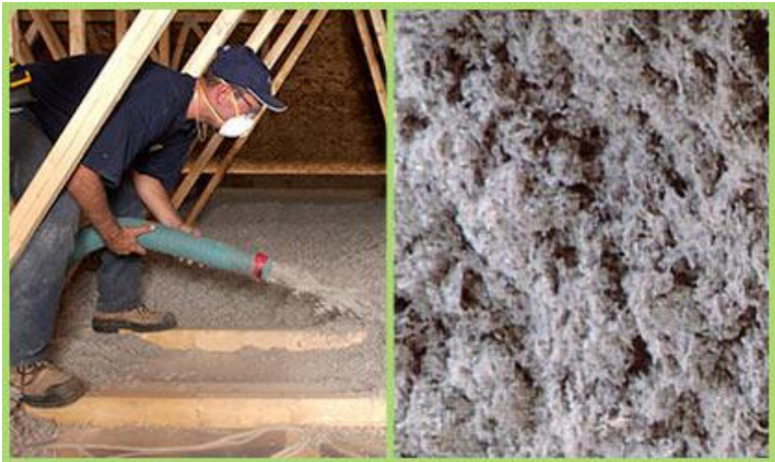
Slika 4.13 Ugradnja celuloze metodom špricanja
