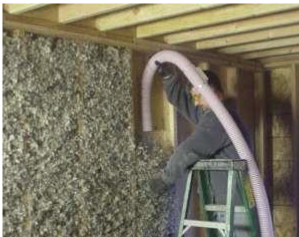
Slika 4.21 Ugradnja ovčje vune
