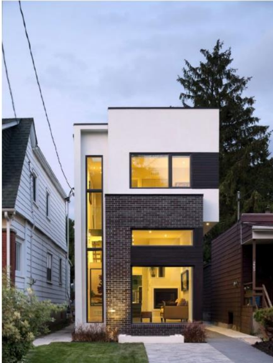
Slika 4.25 Kuća sa nano izolacijskim materijalima u Torontu
