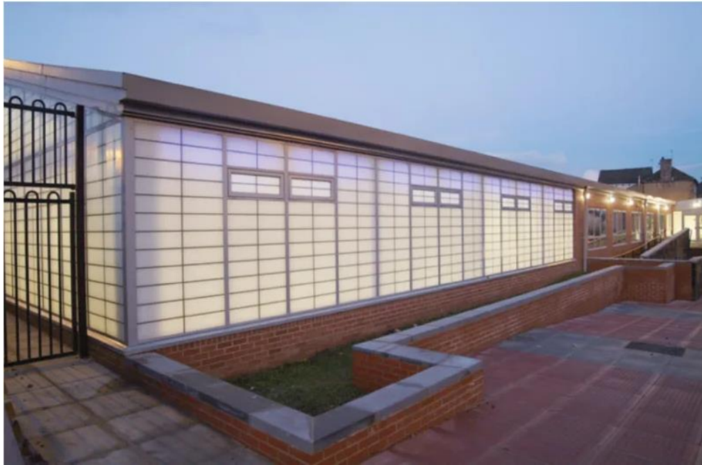
Slika 4.30 Osim za izolaciju, aerogel se može koristiti u konstrukciji staklene kuće
