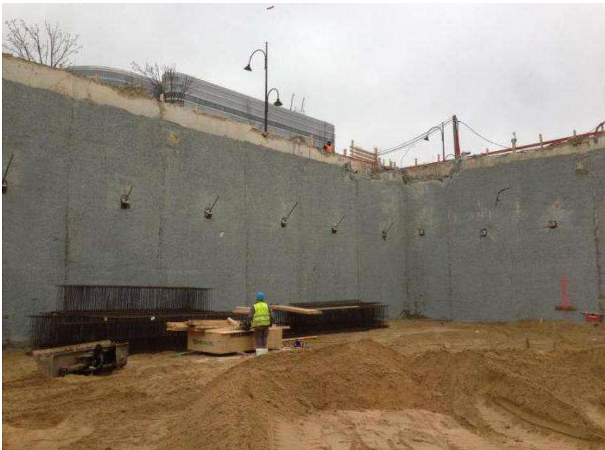
*Slika 2.11. Armiranobetonska dijafragma.*
