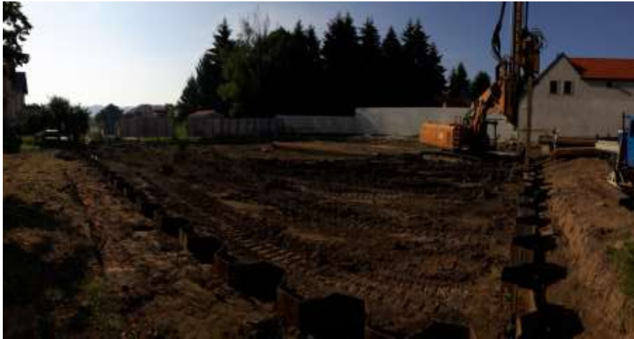
Slika 5.2. Zabijanje čeličnog žmurja.
