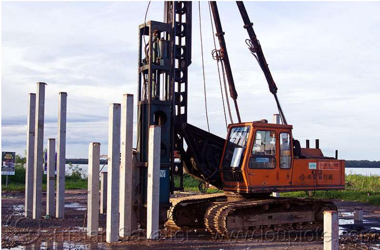
*Slika 2.10. Armiranobetonsko žmurje.*
