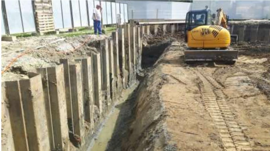
*Slika 5.4. Iskop drenažnih kanala*
