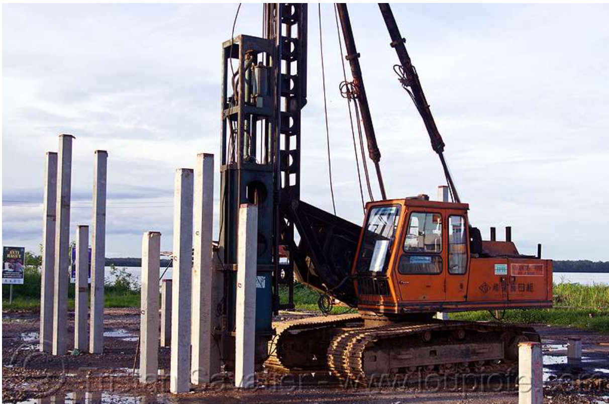
Slika 2.10. Armiranobetonsko žmurje.
