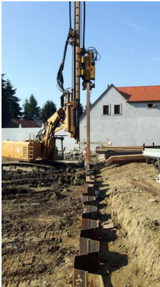
Slika 5.1. Zabijanje čeličnog žmurja.
