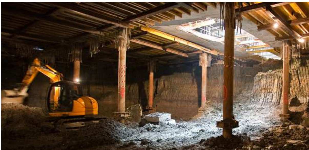
Slika 2.13. Izvedba podzemne garaže top-down metodom , „Cvjetni trg“, Zagreb.
