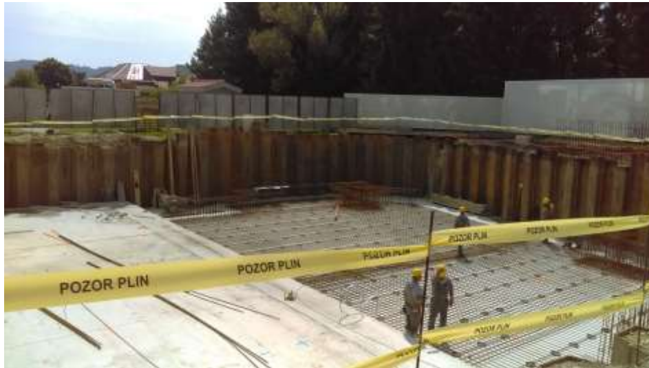
Slika 5.8. Radovi u građevinskoj jami.
