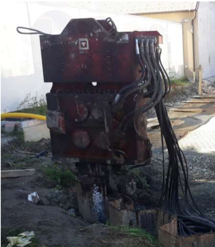
Slika 5.3. Nastavak za zabijanje žmurja.
