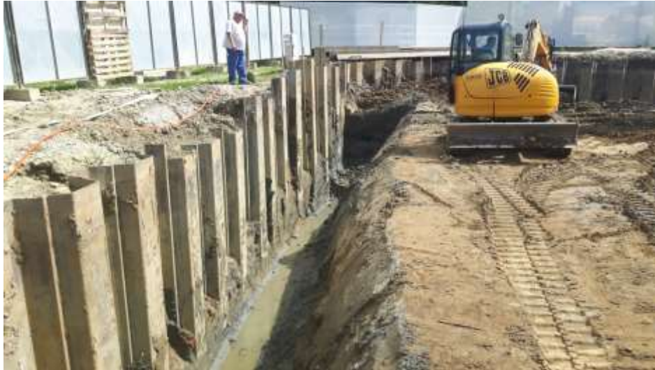
Slika 5.4. Iskop drenažnih kanala
