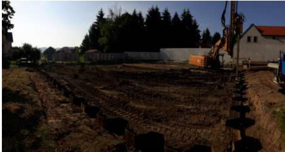
Slika 5.2. Zabijanje čeličnog žmurja.
