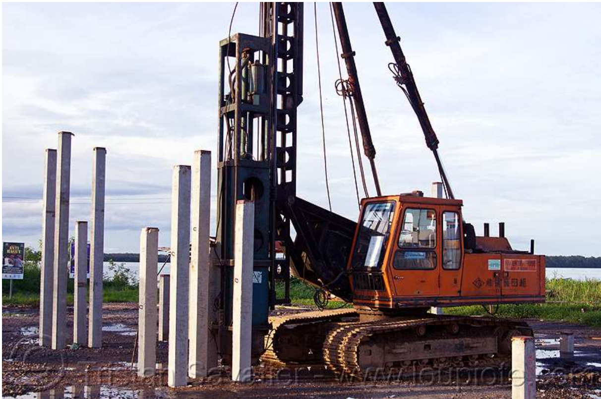
Slika 2.10. Armiranobetonsko žmurje.
