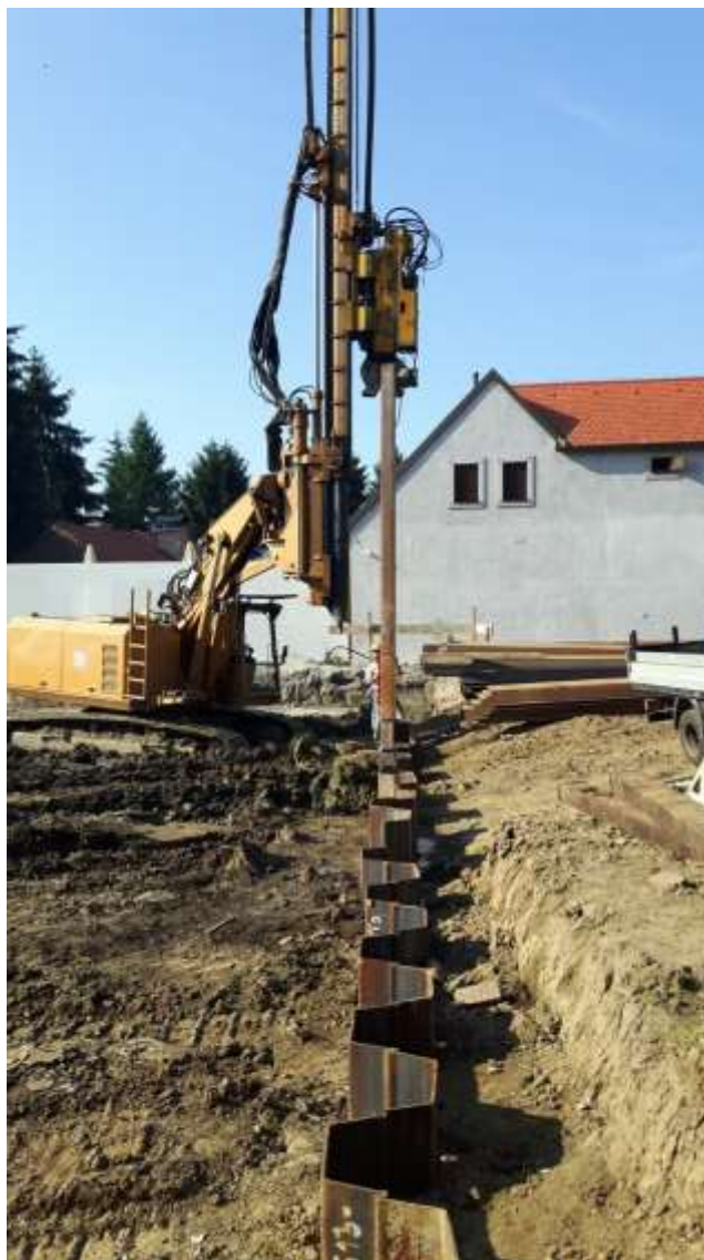
Slika 5.1. Zabijanje čeličnog žmurja.
