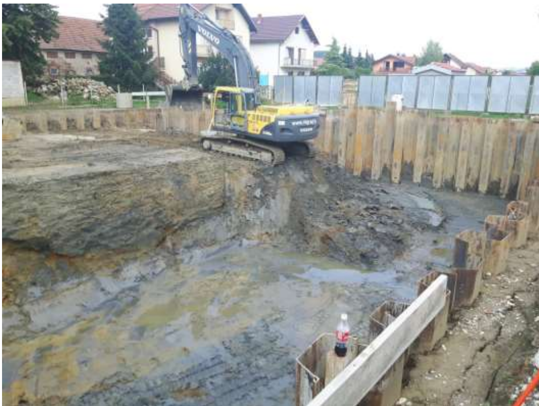
Slika 5.7. Iskop u građevinskoj jami.
