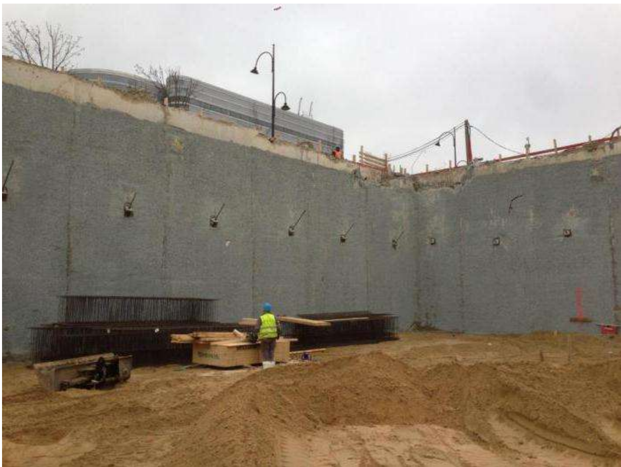
Slika 2.11. Armiranobetonska dijafragma.
