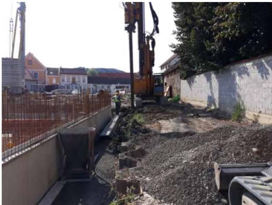
Slika 5.9. Vađenje žmurja iz tla.
