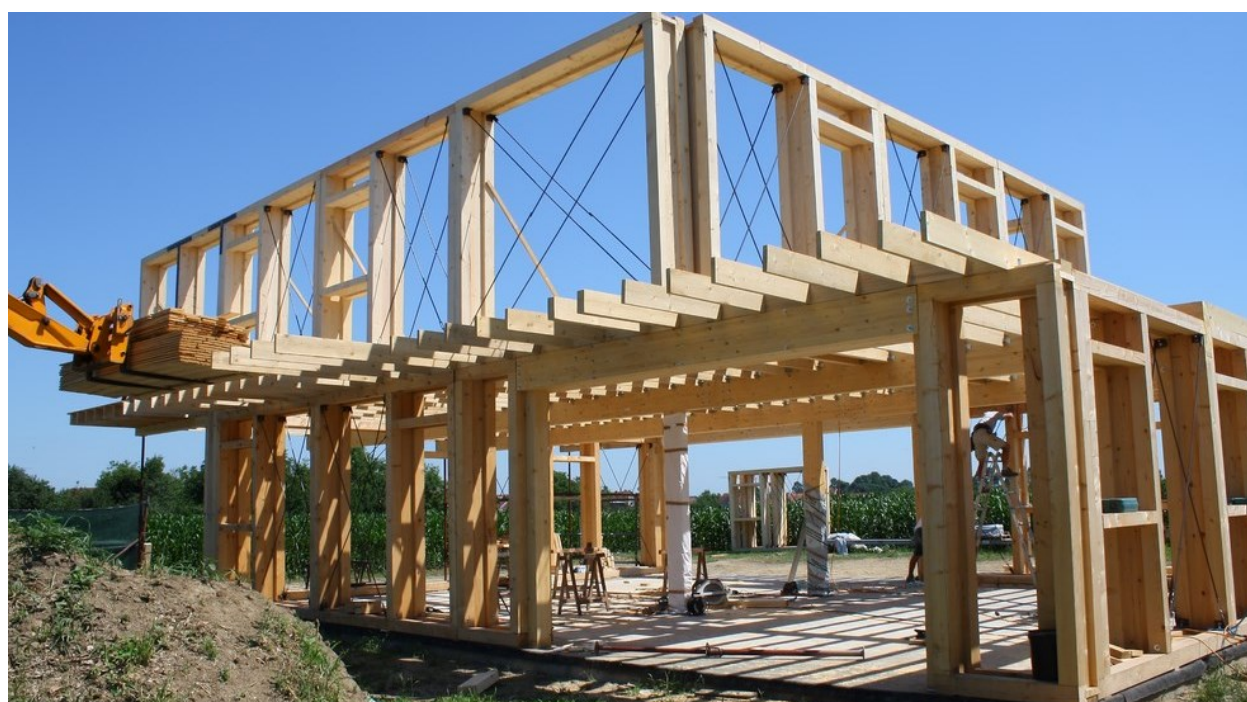
Slika 3.4 Drveni nosivi sustav
