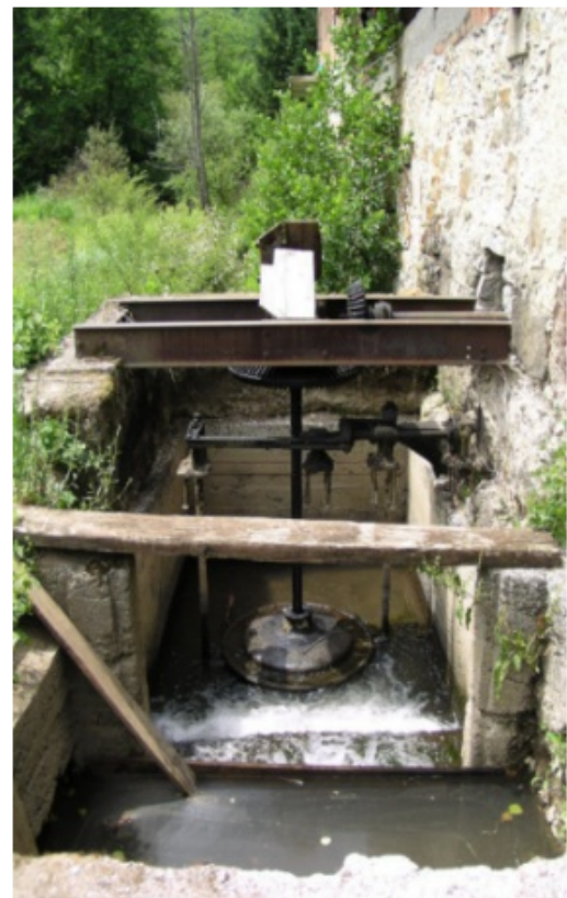
Slika 3.12 Primjer iskorištenja mehanizma starog mlina za mini hidroelektranu
