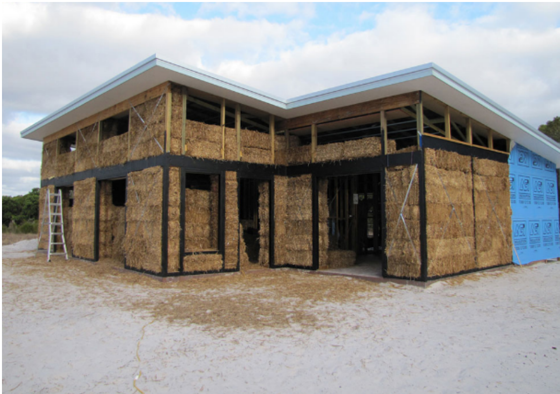
Slika 3.3 Slama izolacijska ispuna
