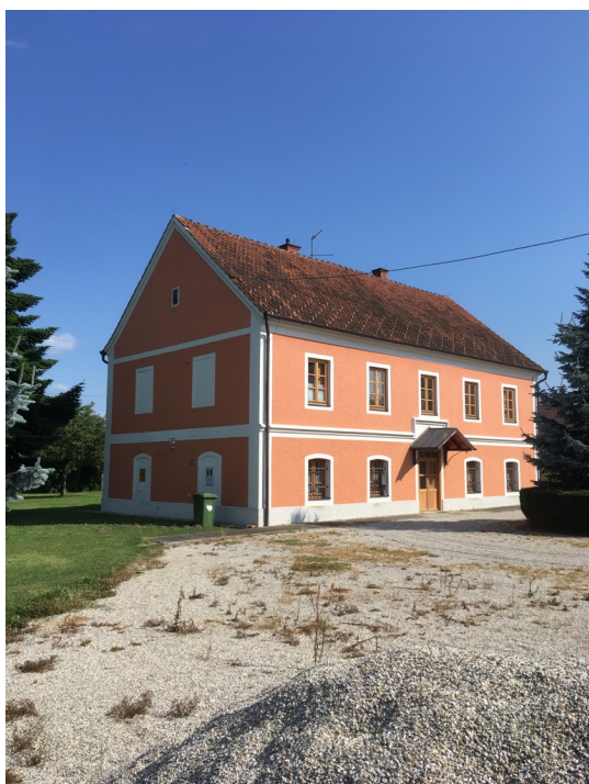
Slika 2.22 Sjeverozapadna strana Župnog dvora
