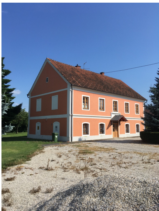
Slika 2.22 Sjeverozapadna strana Župnog dvora
