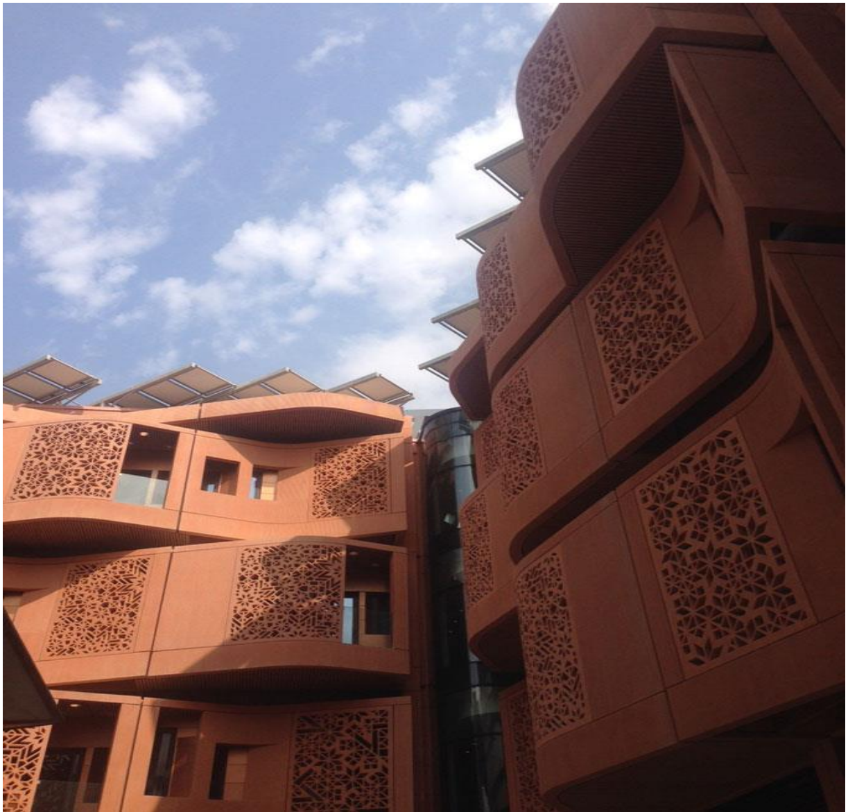
Slika 4. Neobičan oblik krova i zgrade
