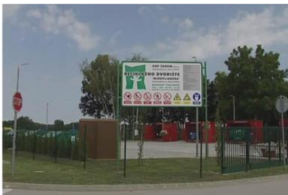
Slika 23: Reciklažno dvorište Mihovljan
