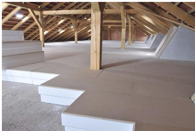
Slika 3.11. Postavljanje EPS-a u potkrovlje
