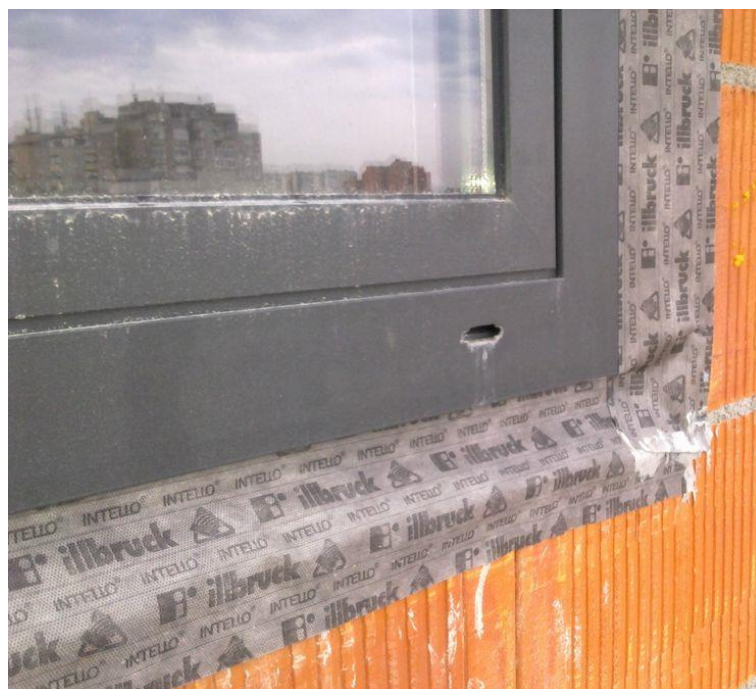
Slika 3.16. Montaža prema RAL smjernicama
