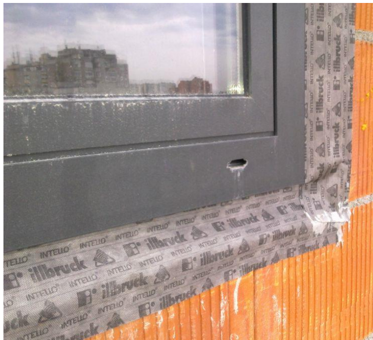
Slika 3.16. Montaža prema RAL smjernicama
