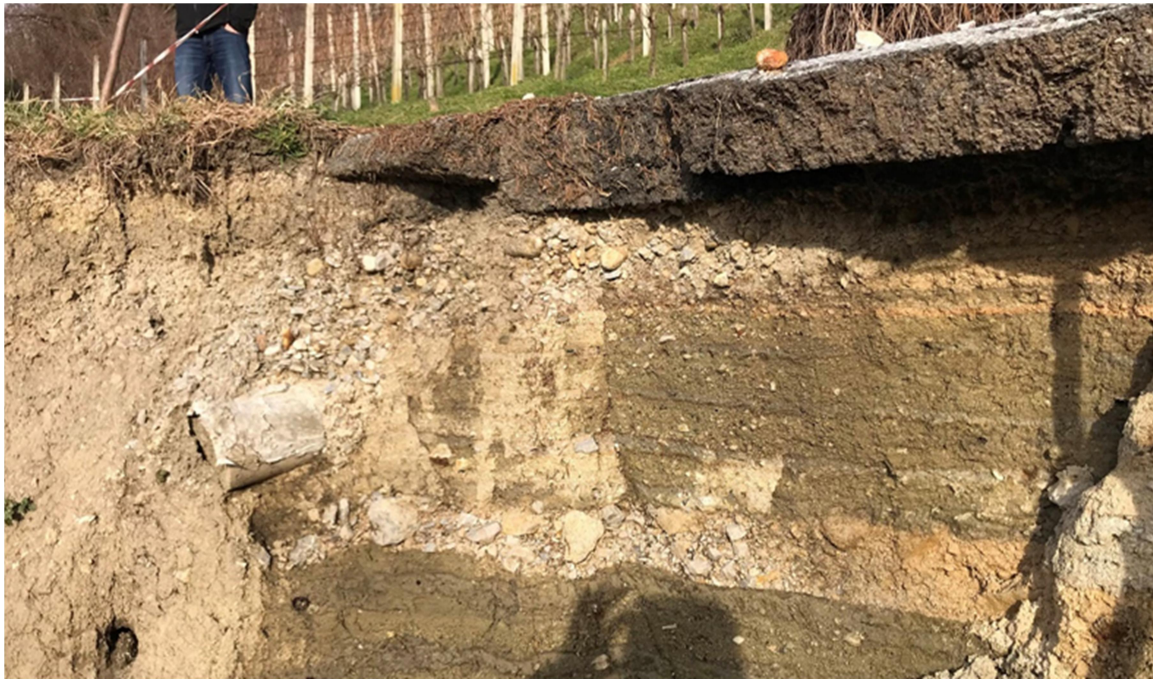
Slika 10. Izlaz cijevi u tijelo klizišta (cijev zaštopana)
