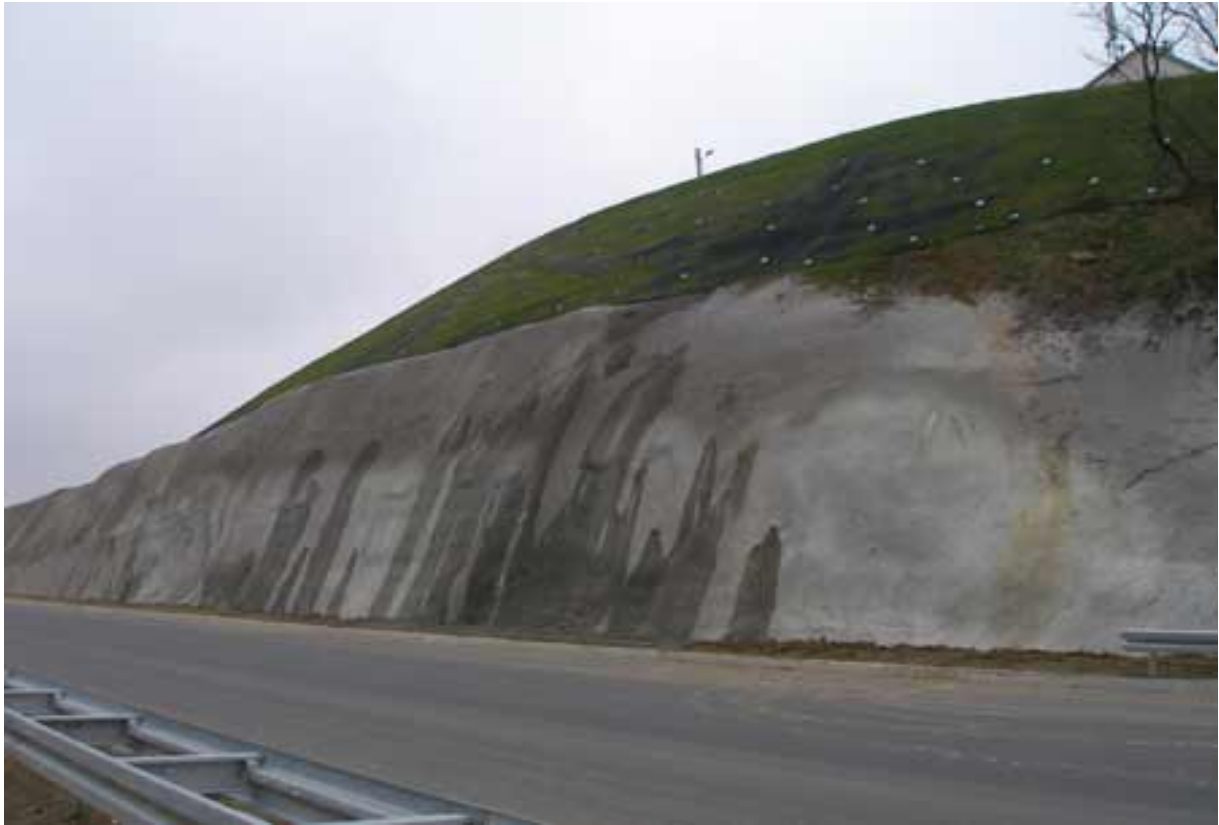
Slika 3. Prikaz mlaznog betona na jednom pokosu
