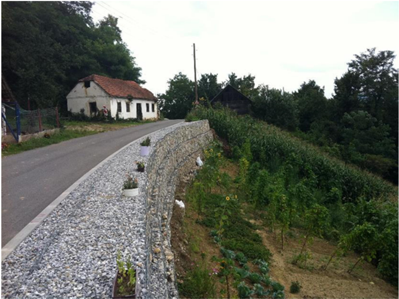
Slika 23. Izvedeni gabionski zid
