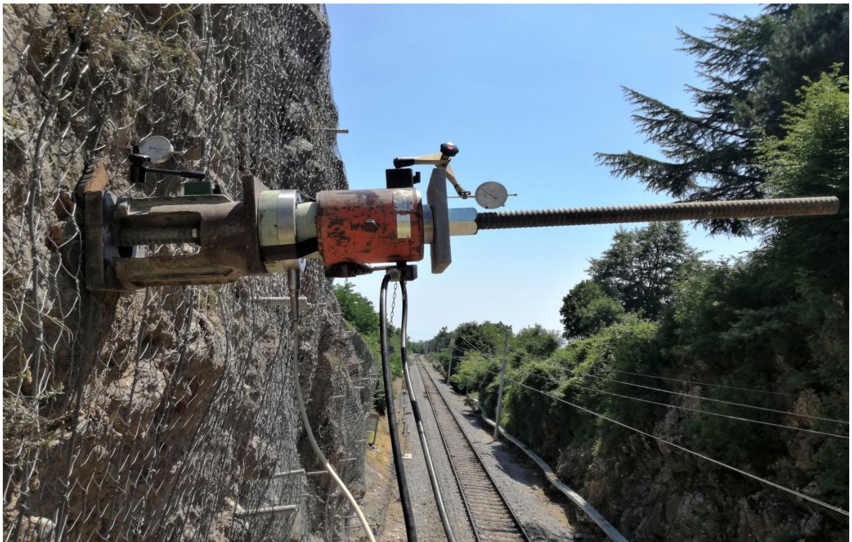
Slika 4. Geotehničko sidro
