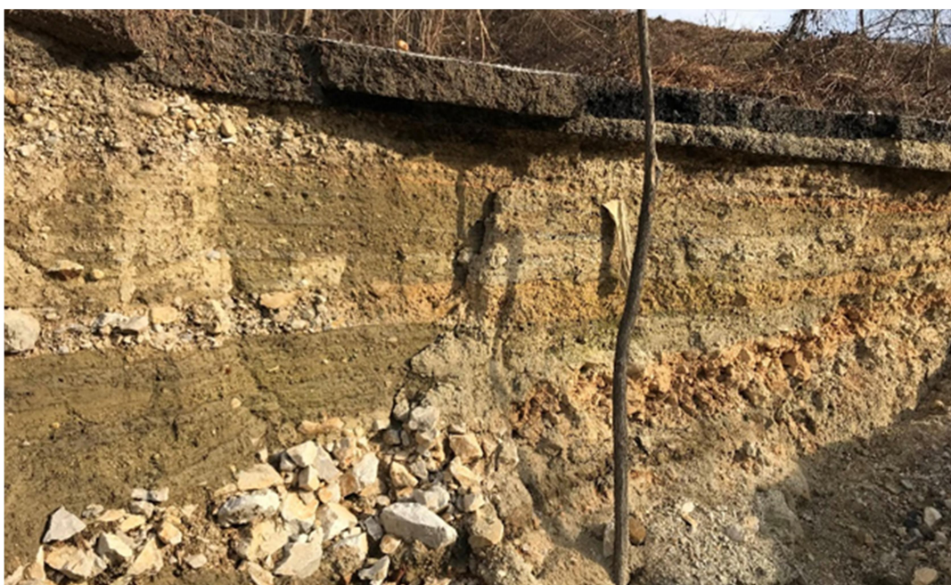
Slika 12. Pogled na slojeve nasipa ispod ceste
