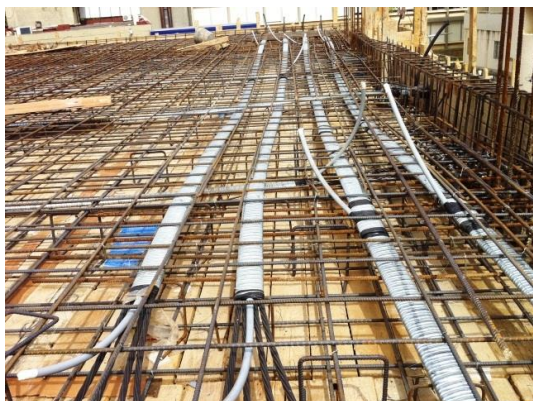
Slika 2.3. Bonded tehnologija
