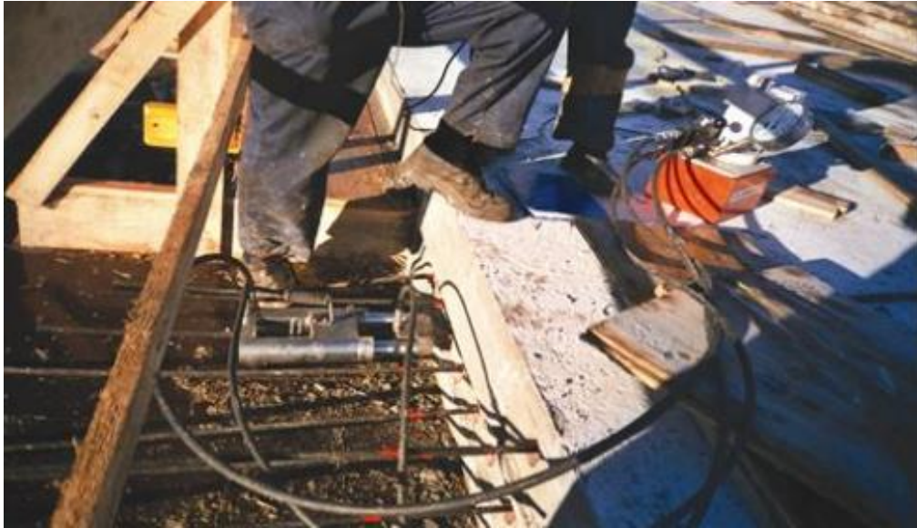
Slika 2.12. Unosi sile hidrauličkom prešom
