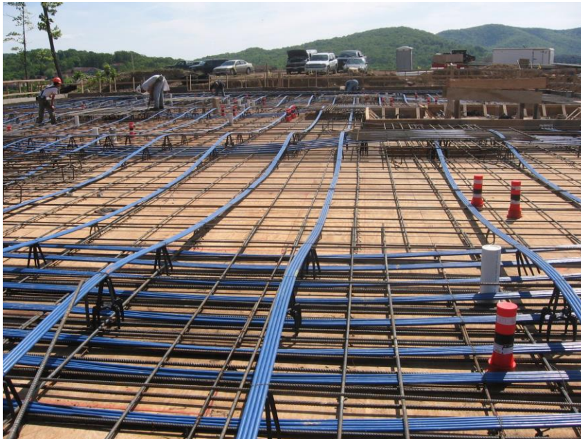
Slika 2.2. Postavljeni kabeli na stropnoj ploči u izradi
