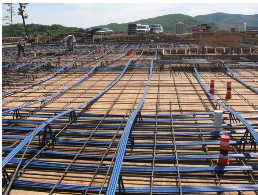
*Slika 2.2. Postavljeni kabeli na stropnoj ploči u izradi*
