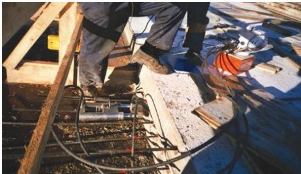
Slika 2.12. Unosi sile hidrauličkom prešom
