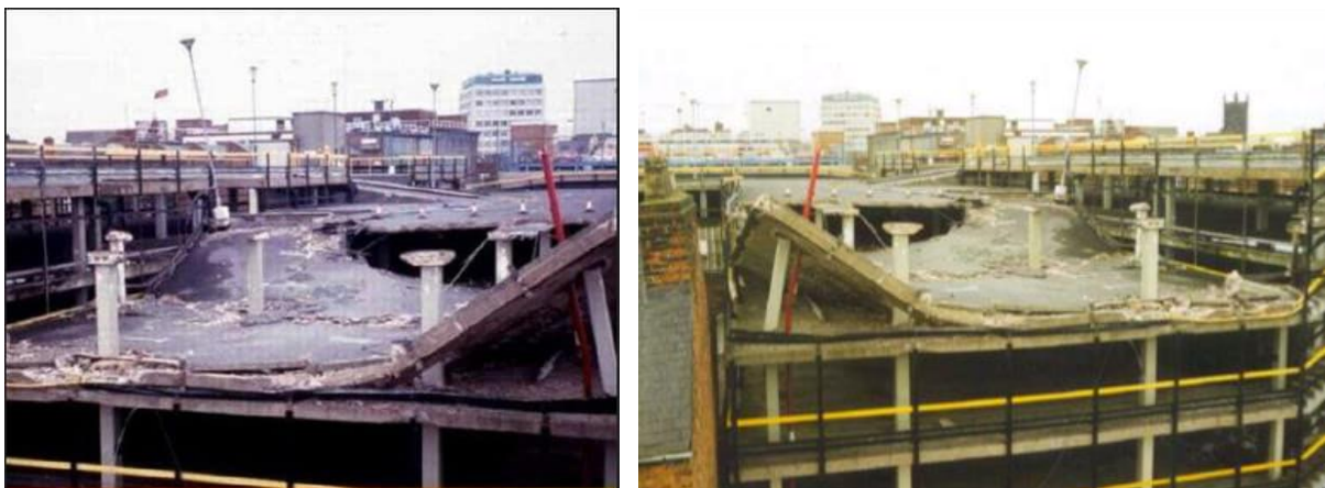
Slike 3.2. i 3.3. Proboj gornje etaže parkirališta
