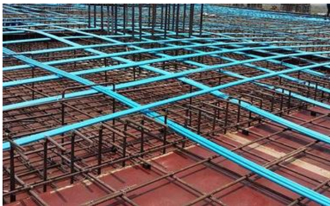
Slika 2.4. Unbonded tehnologija
