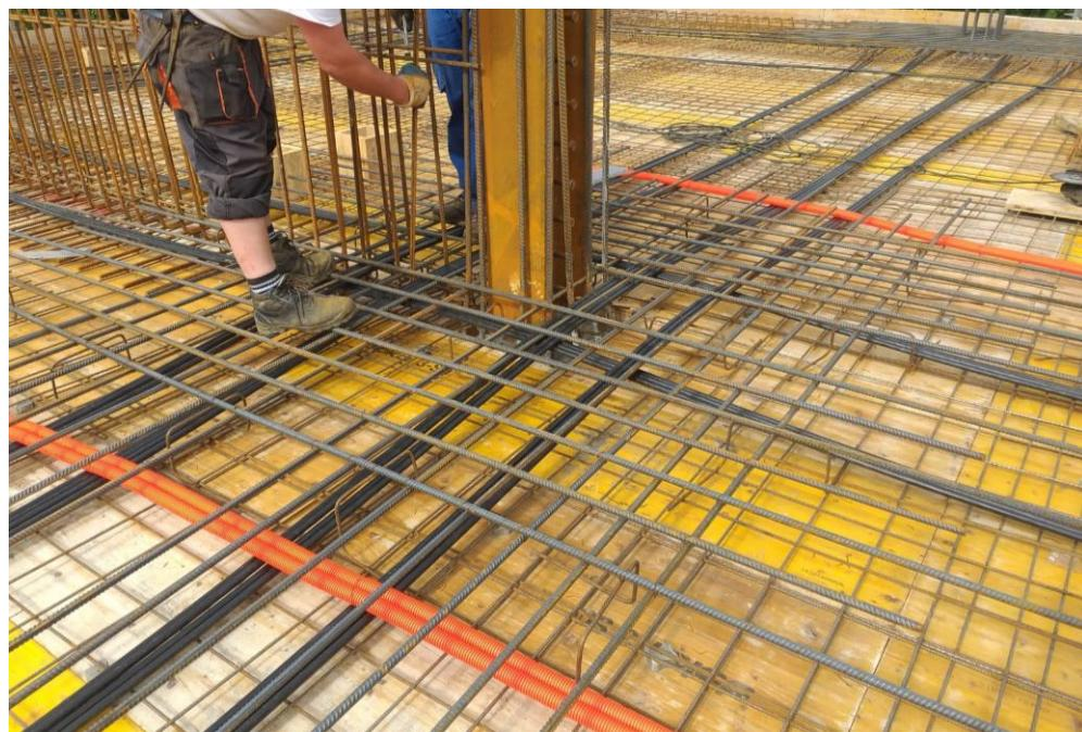
Slika 2.13. Slobodno vođenje kabela na gradilištu
